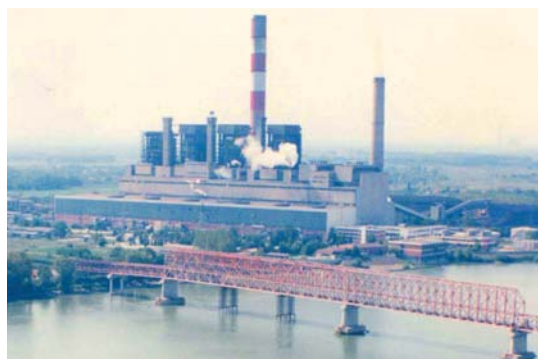
12 • AŽD PRAHA SE PODÍLÍ NA MODERNIZACI NEJVĚTŠÍ SRBSKÉ TEPELNÉ ELEKTRÁRNY
