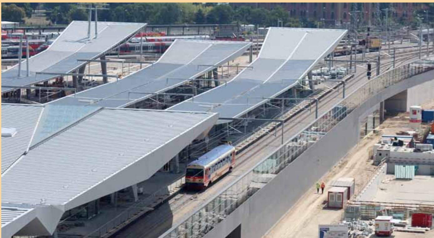
Motorový vůz ř. 5047, který je pro rakouské lokálky stejně neodmyslitelný jako řada 810 pro ty naše, projíždí jako služební vlak přes staveniště hlavního nádraží (snímek z června 2012)
