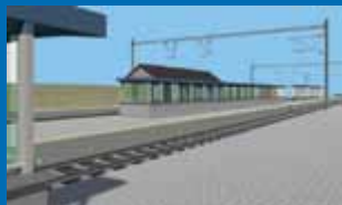
Železniční stanice Chotoviny projde výraznou změnou. Nástup a výstup cestujících ulehčí nové ostrovní a vnější nástupiště. Přístup na nástupiště zajišťují bezbariérové přístupové chodníky, podchod a výtah. Čekání na vlak zpříjemní nové přístřešky. Nový informační systém zvýší přehled nejen o pravidelných odchodech a příchozech vlaků osobní dopravy, ale i o mimořádnostech provozu.
