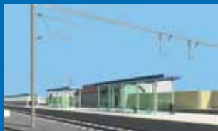
Železniční stanice Chotoviny projde výraznou změnou. Nástup a výstup cestujících ulehčí nové ostrovní a vnější nástupiště. Přístup na nástupiště zajišťují bezbariérové přístupové chodníky, podchod a výtah. Čekání na vlak zpříjemní nové přístřešky. Nový informační systém zvýší přehled nejen o pravidelných odchodech a příchozech vlaků osobní dopravy, ale i o mimořádnostech provozu.
