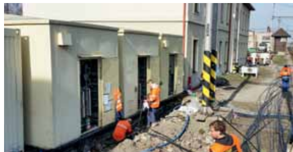
44 • OBNOVA ZABEZPEČENÍ PROVOZU VE STANICI BOHUMÍN PROVEDENA V REKORDNÍM ČASE
