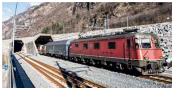
62 • GOTTHARDSKÝ TUNEL JE CHLOUBOU EVROPSKÉ ŽELEZNICE A MÁ HNED DVĚ SVĚTOVÁ PRVENSTVÍ
