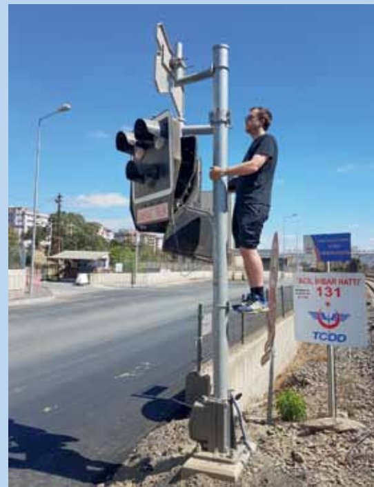
Petr Ševčík z divize Teleinformatiky při instalaci nové verze softwaru do LED výstražníku PZZ-J ve stanici Liman
