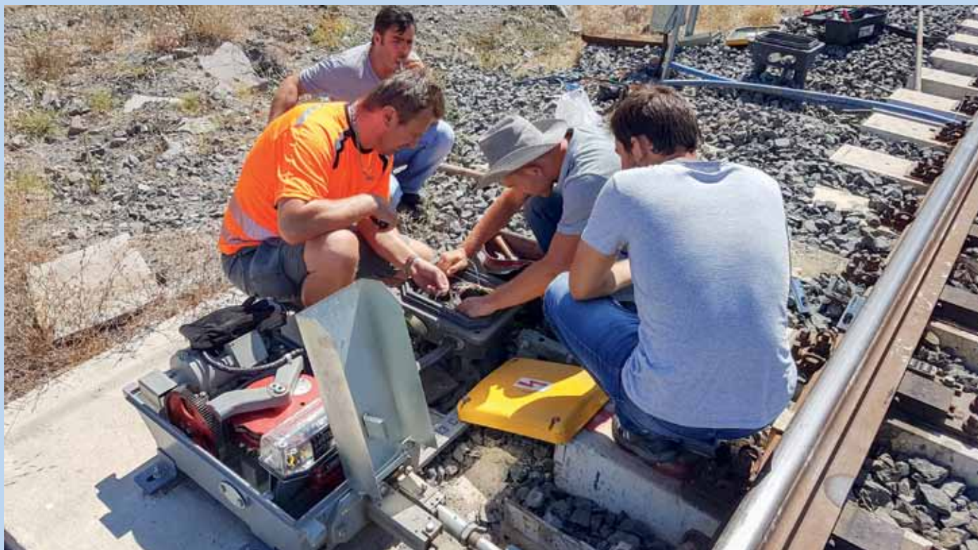
Pracovníci MZ Olomouc a Ultra Teknoloji, která zodpovídá za instalace venkovních prvků, při montáži a testování přestavníku AŽD Praha EP674 ve stanici Tekirdag
