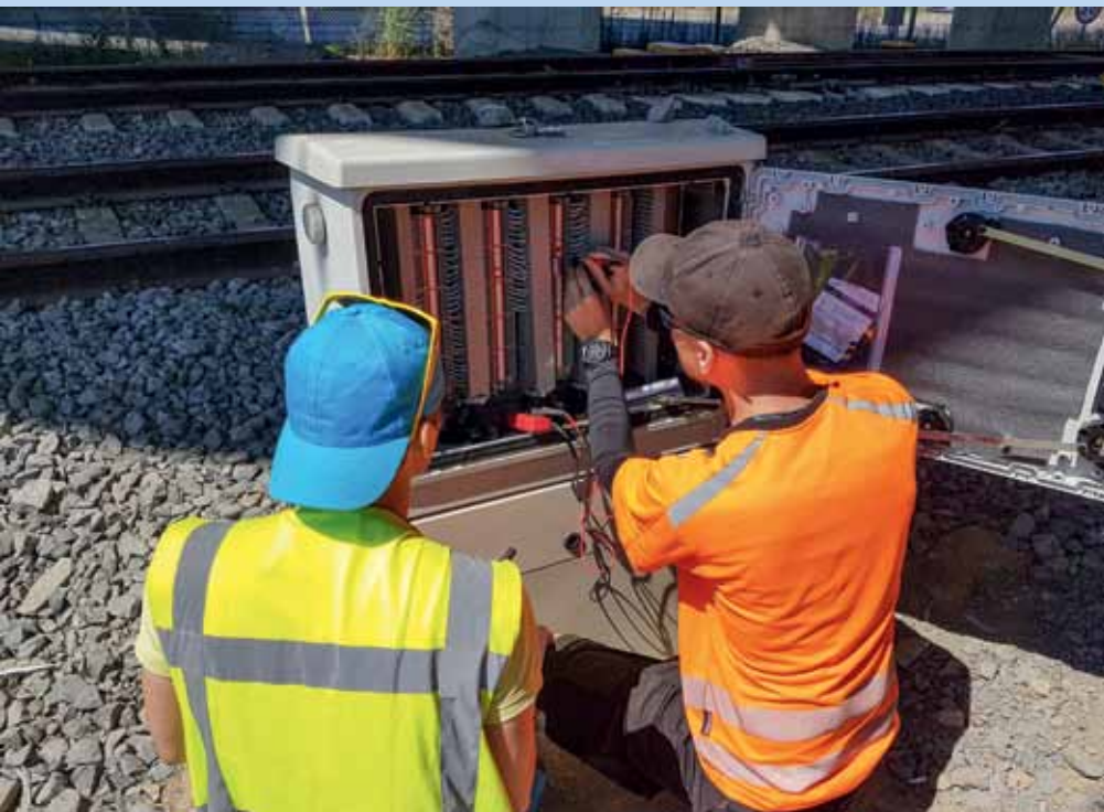
Pracovníci Montážního závodu Olomouc při zapojování a testování průběhu kabelů ve venkovním kabelovém rozvaděči ve stanici Tekirdag
