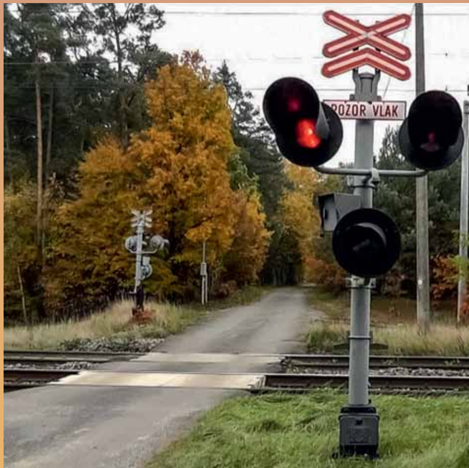
Přejezdové zabezpečovací zařízení světelné (PZS) bez závor vzor SSSR
