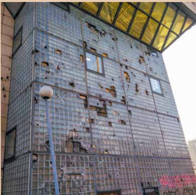
Železniční stanice Sarajevo, budova stavědlové ústředny
