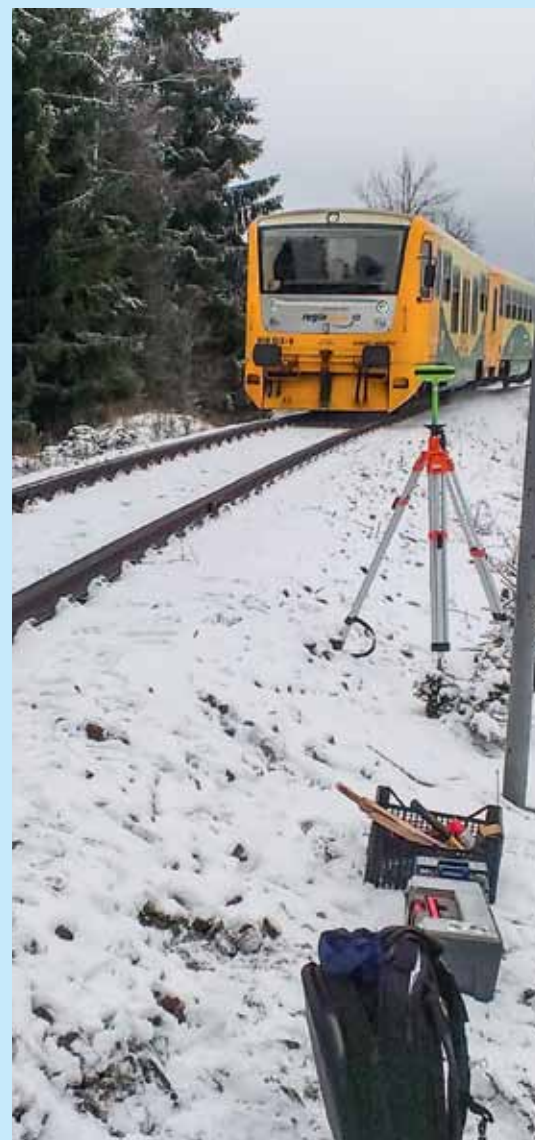
Obr. 5 Geodetické zaměření tratě
