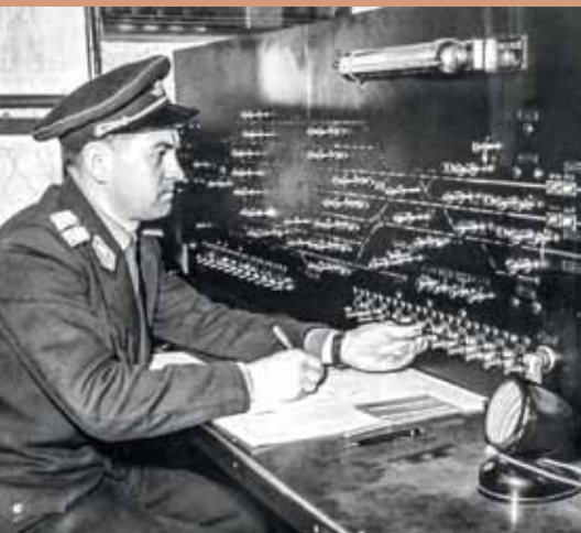
Jedno z prvních staničních reléových zabezpečovacích zařízení bylo zprovozněno v roce 1954 v žst. Třebovice v Čechách (foto ČTK, Miloš Nesvadba)
