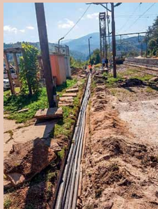
Kabelizace v žst. Blažuj
