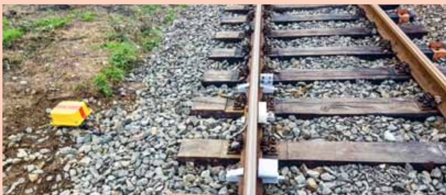
Pilotní montáž hydraulického přestavníku AŽD Praha na pevnou upevňovací soupravu
