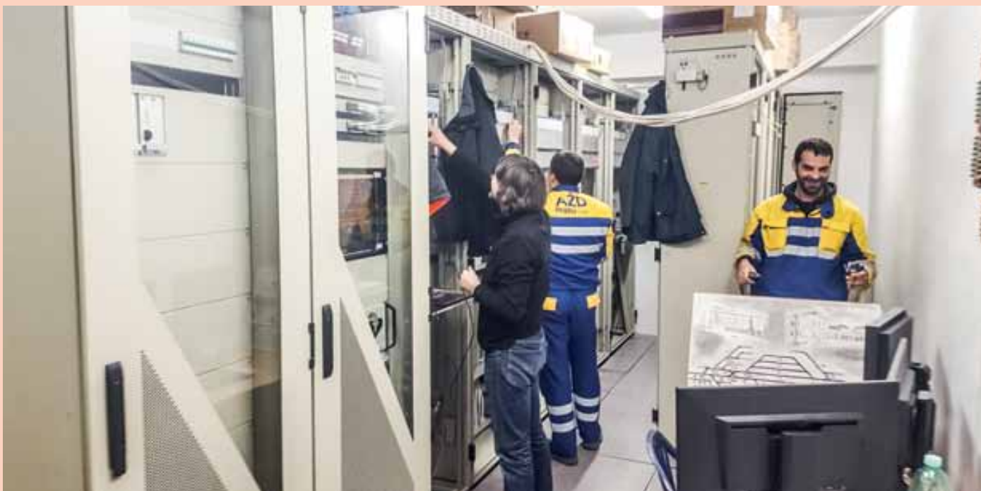
Instalace staničního zabezpečovacího zařízení ESA 44-BH v železniční stanici Banja Luka
