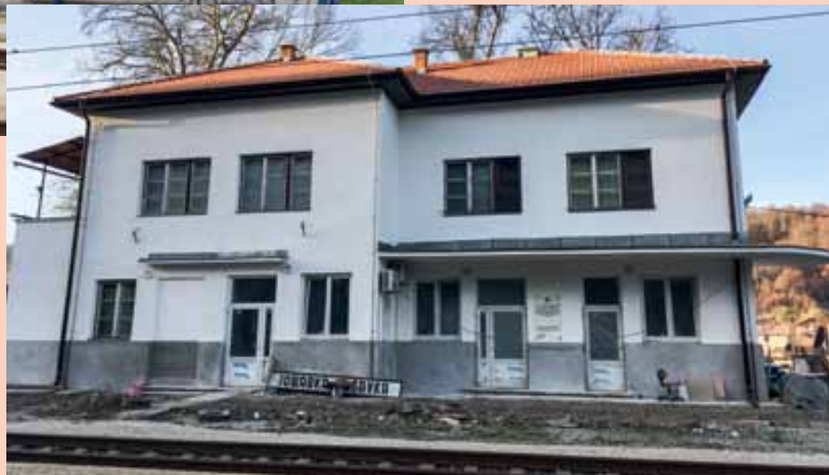
Výpravní budova v Jošavce těsně před dokončením rekonstrukce
