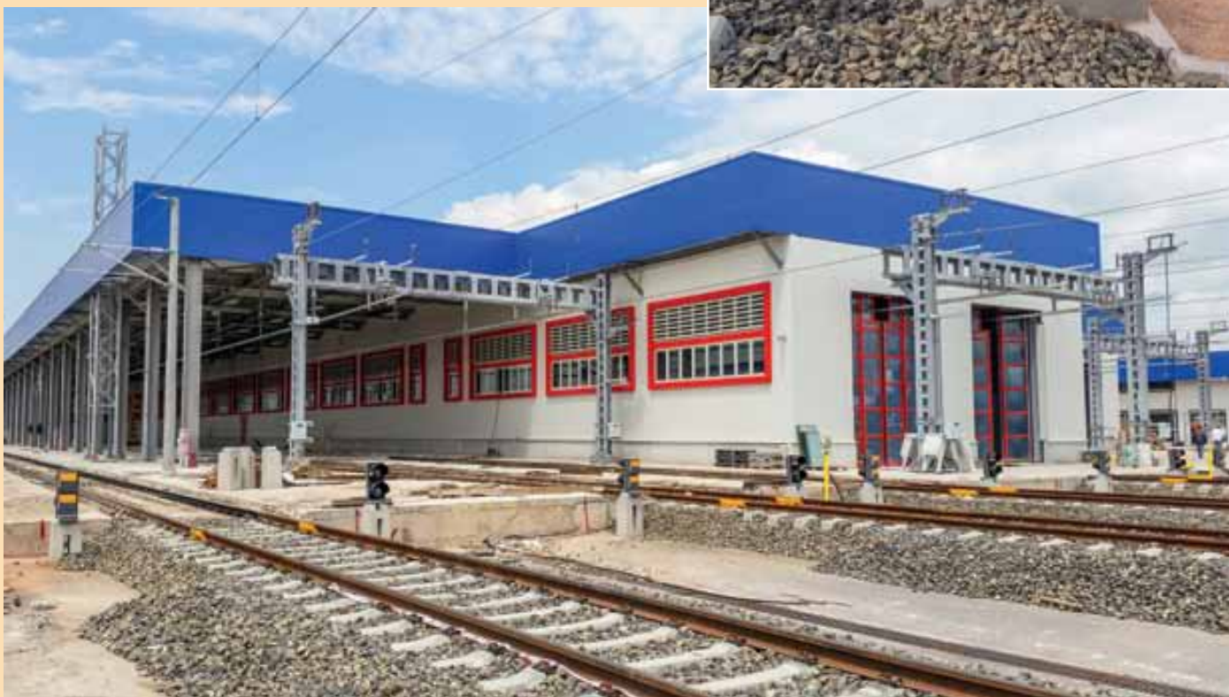
Jedna z údržbářských hal pro vysokorychlostní soupravy před dokončením
