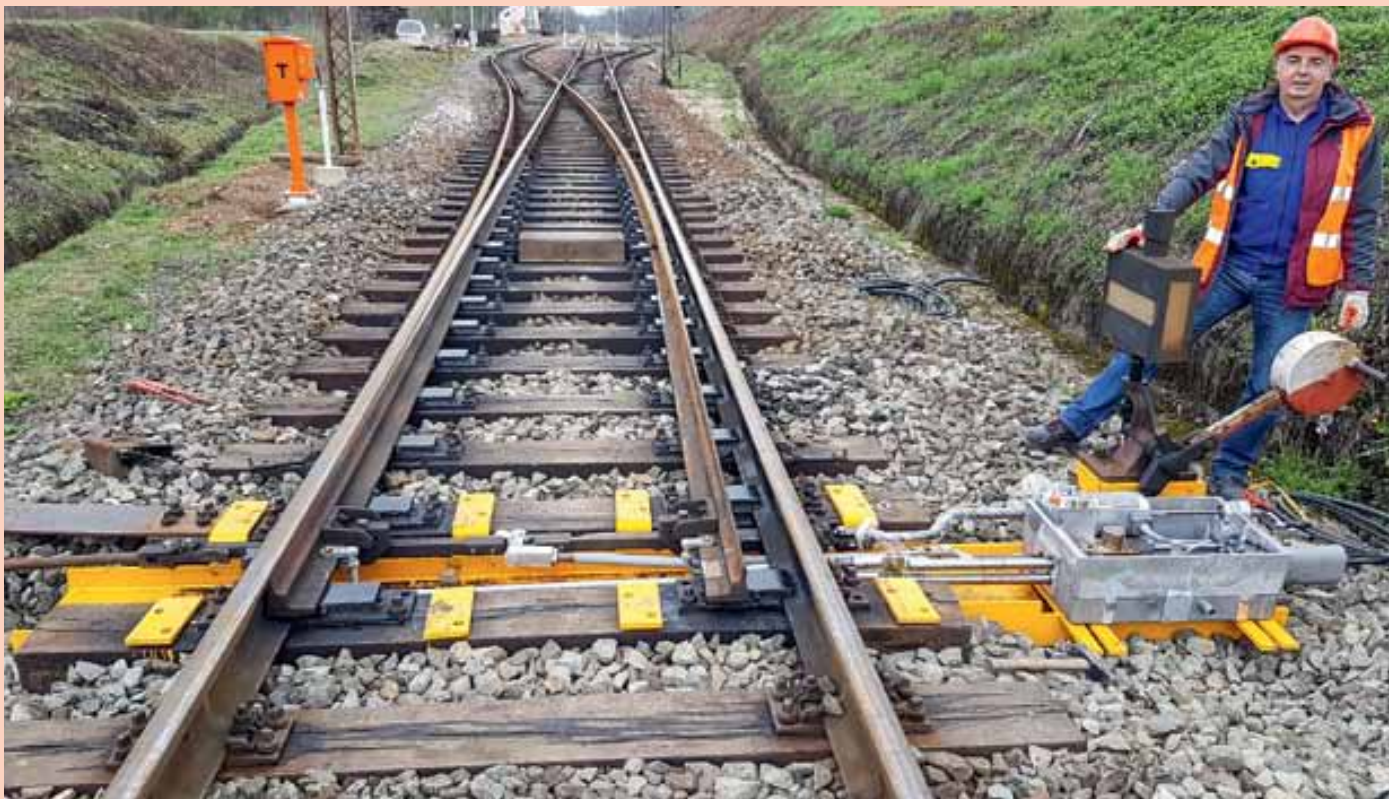
Pilotní montáž hydraulického přestavníku AŽD Praha na pevnou upevňovací soupravu
