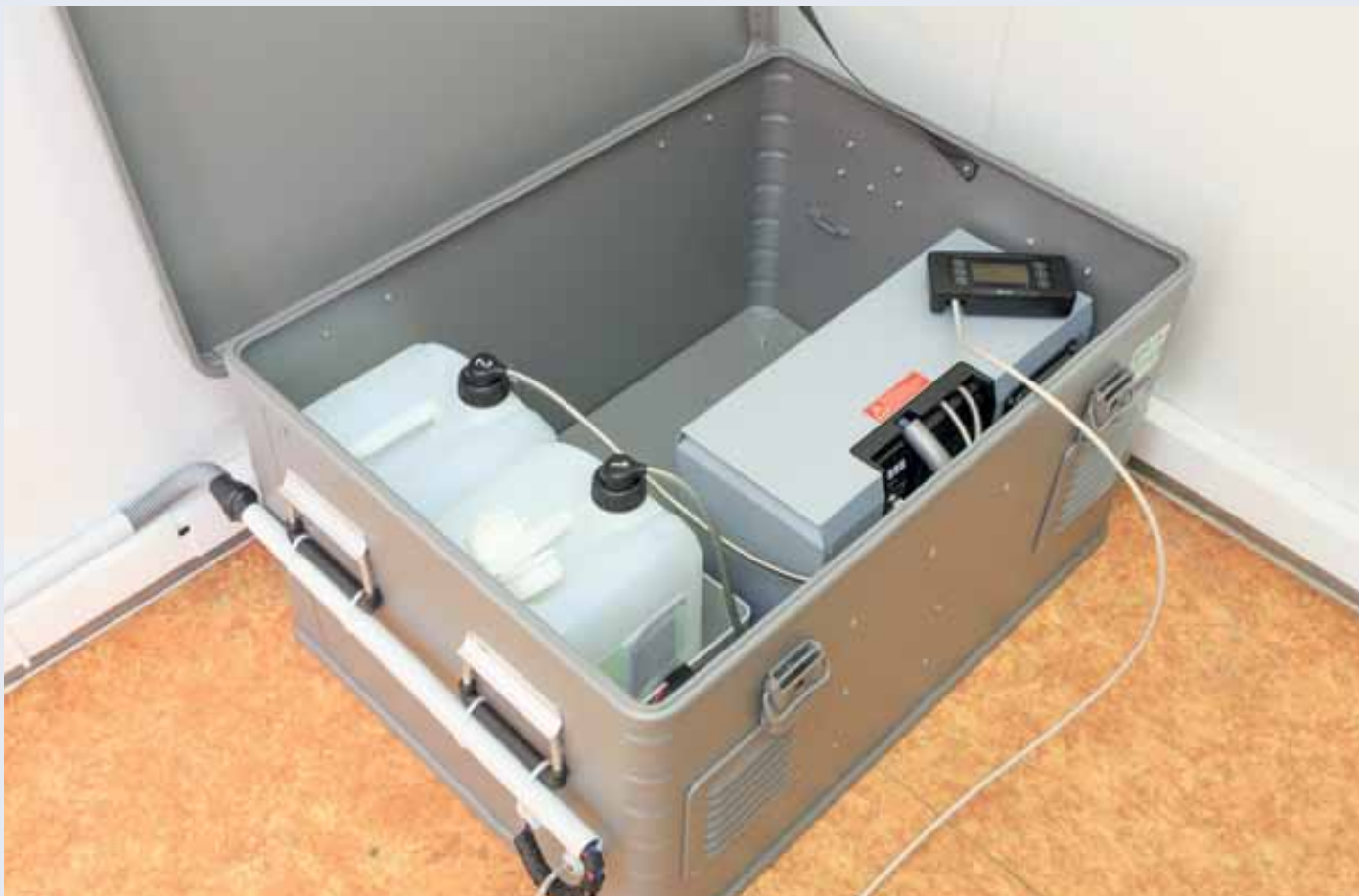
Obr. 4 Připojení zásobníků s palivem k palivovému článku Efoy Pro 2400 Duo v domku PZZ
