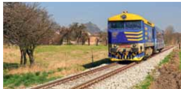
20 • REPORTÁŽ VLAKY.NET: AŽD PRAHA, NOVÝ PROVOZOVATEL ŽELEZNIČNÍ DOPRAVNÍ CESTY MEZI LOVOSICEMI A MOSTEM
