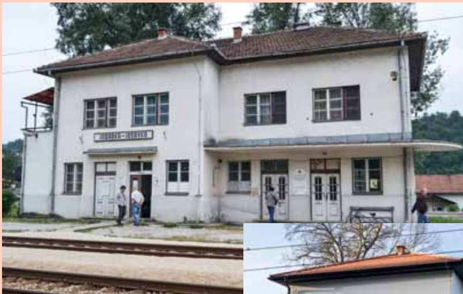
Železniční stanice Jošavka před rekonstrukcí
