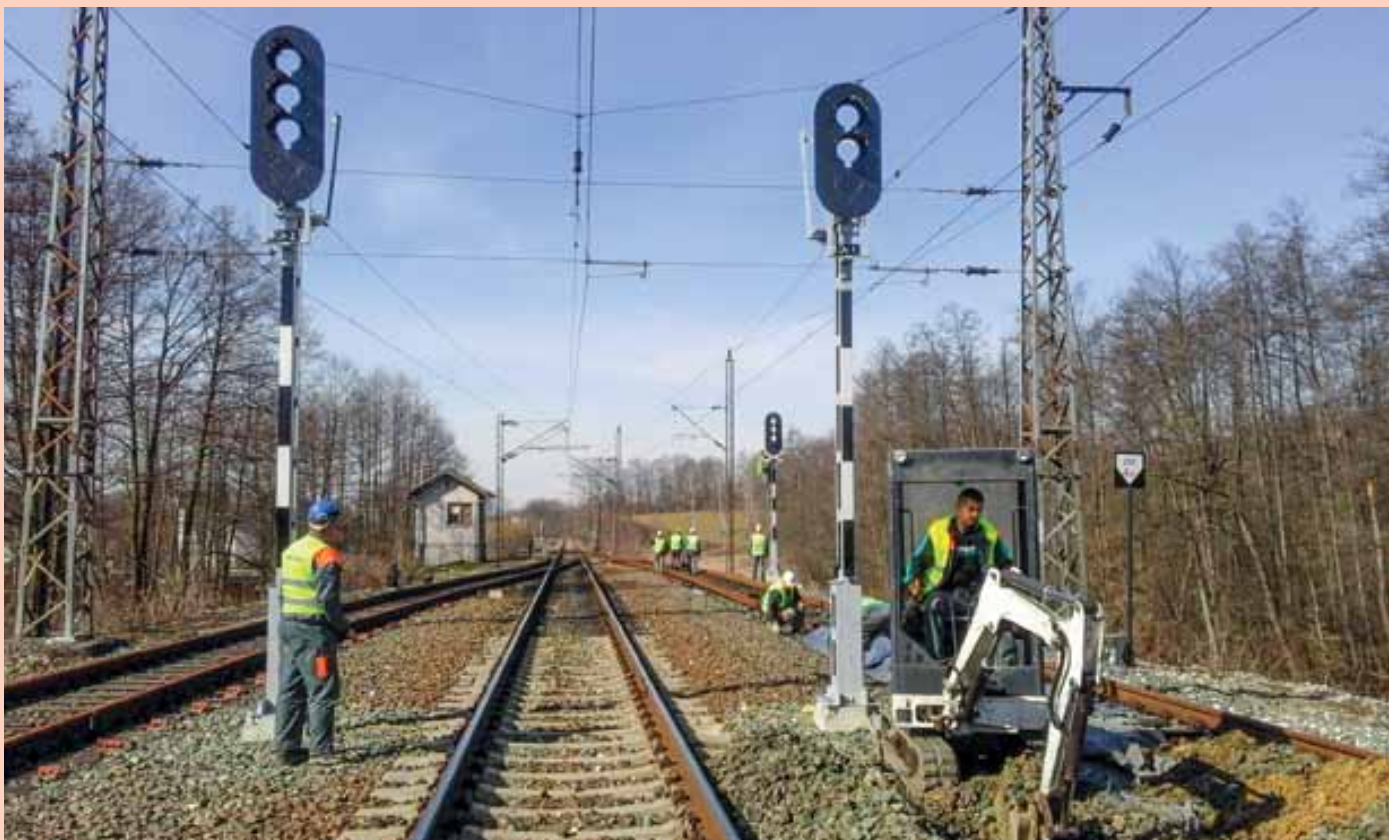
Zemní práce a kabelizace ve stanici Ostružnja
