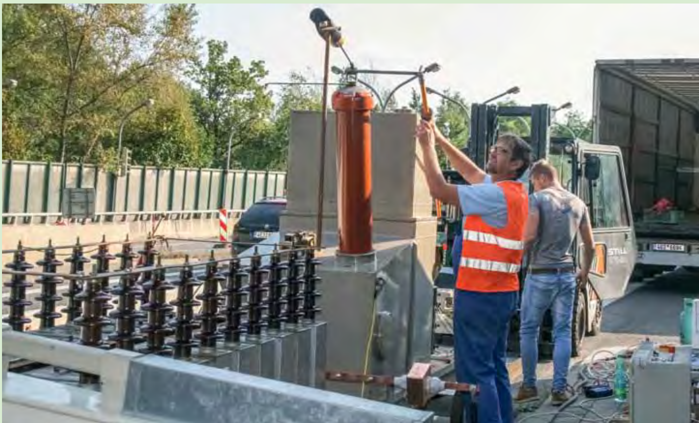
Montáž rázového generátoru pro zkoušky funkčnosti uzemnění
