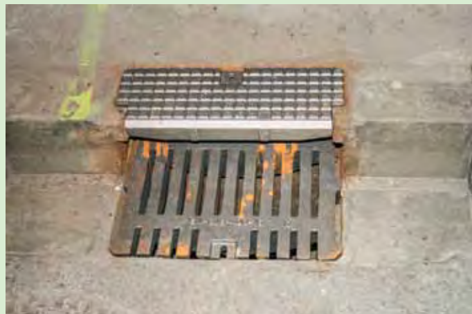
Čištění a výměna uličních vpustí – nová uliční vpust'
