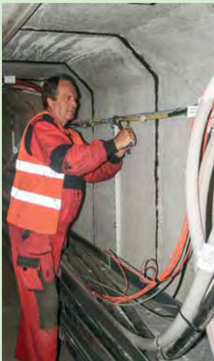
Připojování nového zemnění na stávající uzemnění v průchozí kabelové chodbě pod tunelem
