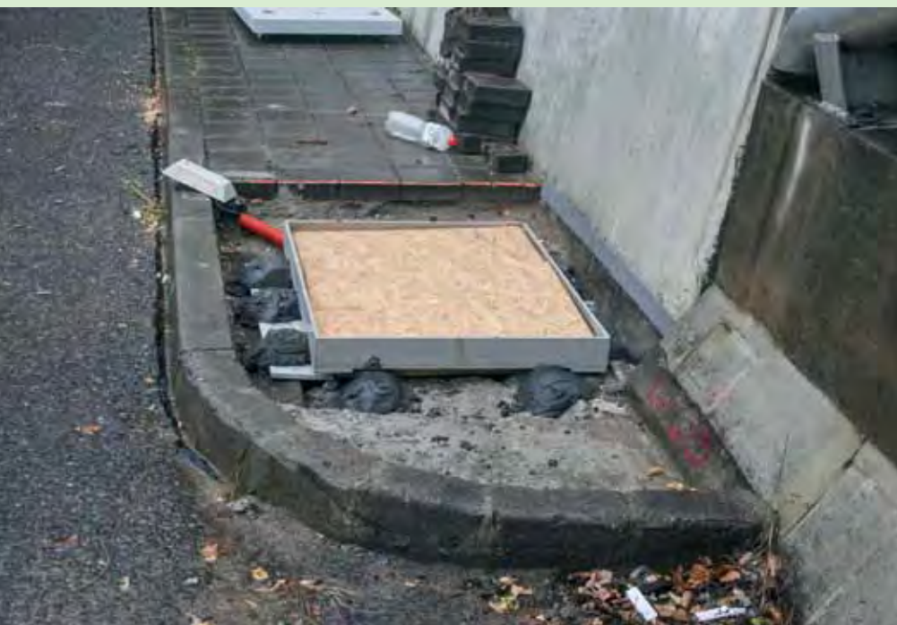
Nový nosný rám poklopu kabelové šachty připravený na zabetonování
