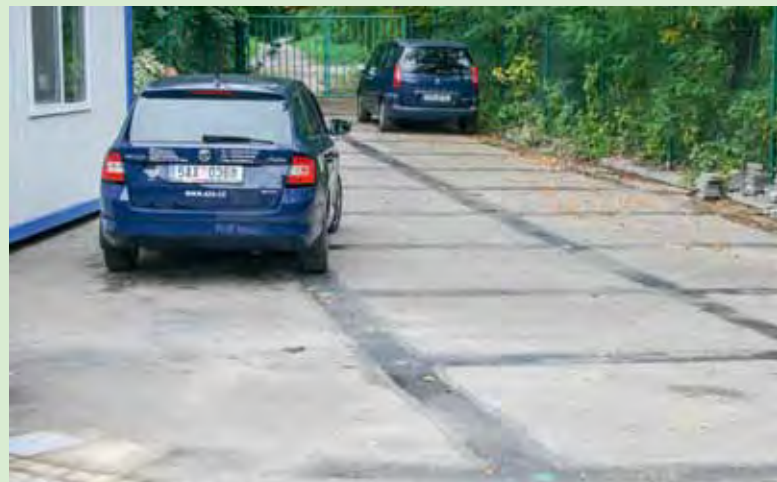
Nová zemní síť na odstavné manipulační ploše před vjezdem do tunelové trouby směrem na Prahu. Pod zelenými body jsou zaraženy zemní tyče, na které je napojena zemní soustava tunelu
