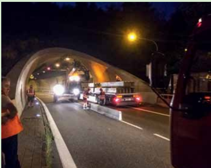
Příprava částečných uzavírek tunelu
