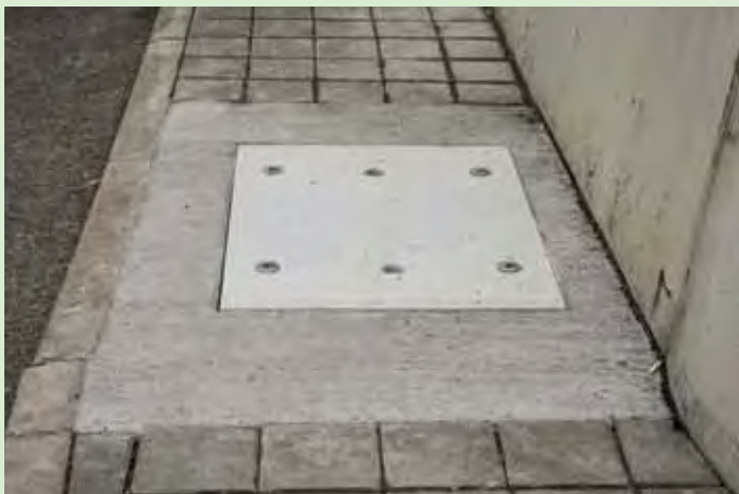
Hotový zalitý rám s osazeným novým poklopem kabelové šachty
