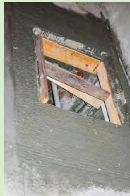
Zabetonování rámu poklopu kabelové šachty před odstraněním bednění a začistěním
