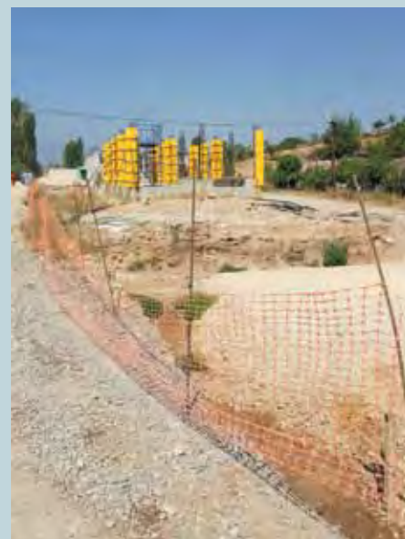
Stanice Šupli Kamen – výstavba staniční budovy
