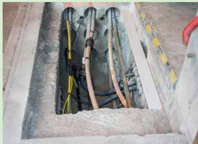
Kabelová šachta před osazením, uvnitř žlutozelený kabel nové zemní soustavy napojený na stávající uzemnění a na technologii
