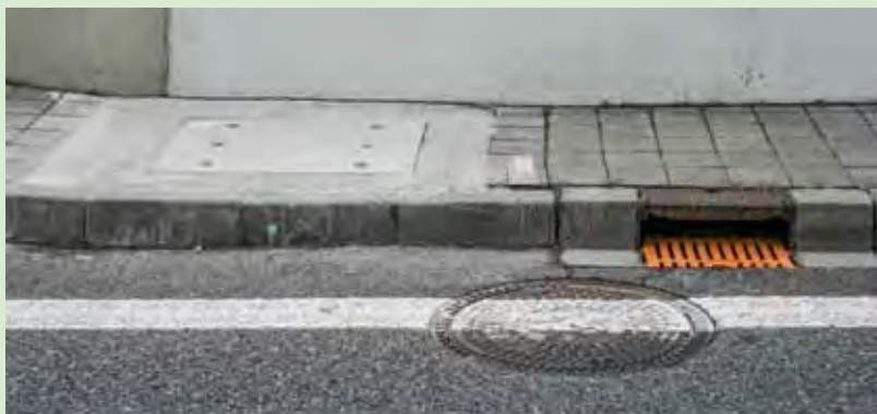
Čištění a výměna uličních vpustí – nová uliční vpust'
