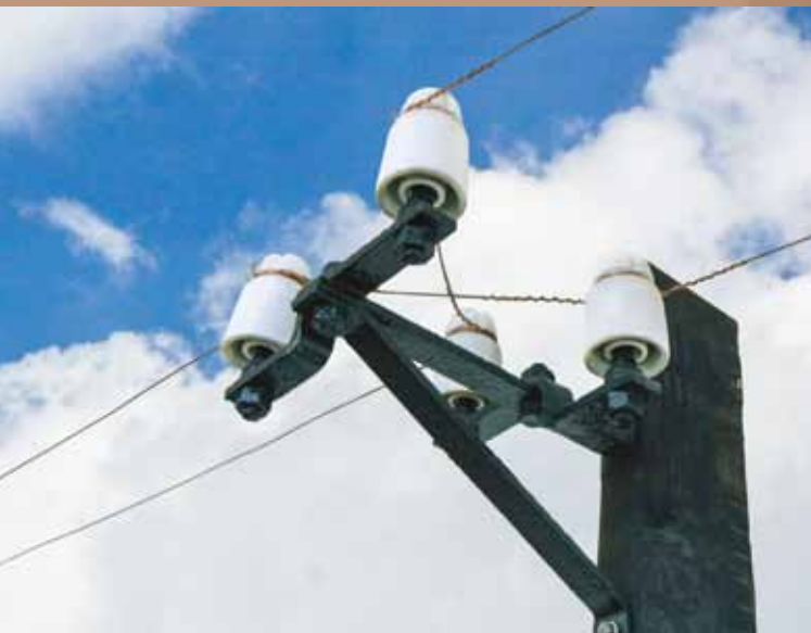
↑ Vykřížování linky nadzemního vedení
