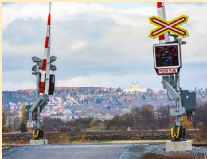
➤ Železniční stanice Uničov
