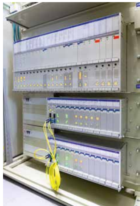
↑ Panely LCI v rámu s panelem EIP
