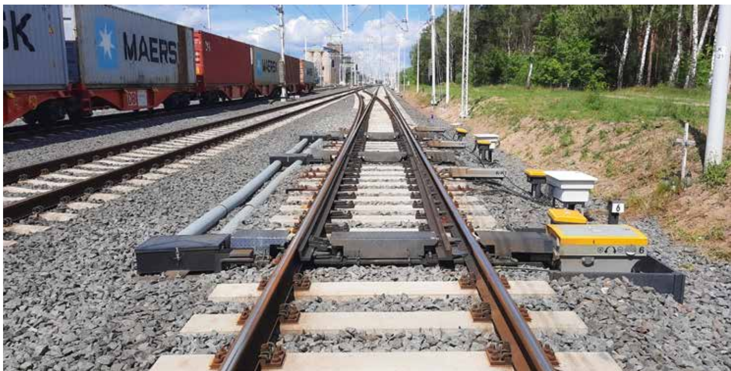
↑ Instalace elektromotorického přestavníku AŽD ve stanici Szamotuły
