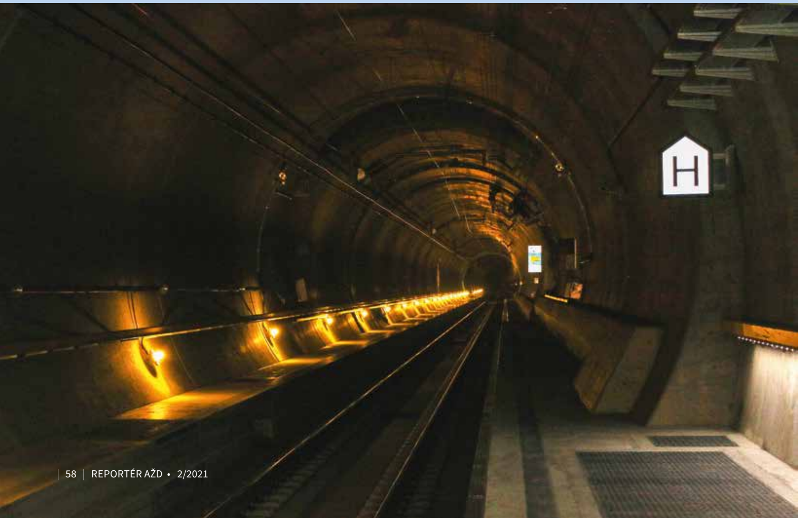
↓ Tubus švýcarského Gotthardského úpatního tunelu před zahájením běžného provozu
