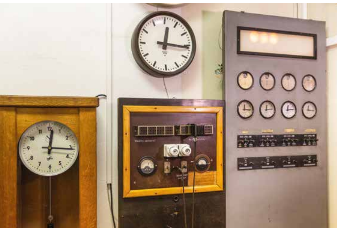
← Zleva: Řídicí hodiny, dřevěný hodinový linkový rozvaděč z pražského Masarykova nádraží, plechový hodinový linkový rozvaděč
