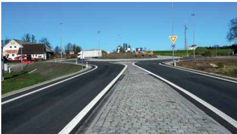
→ Křižovatka po rekonstrukci
