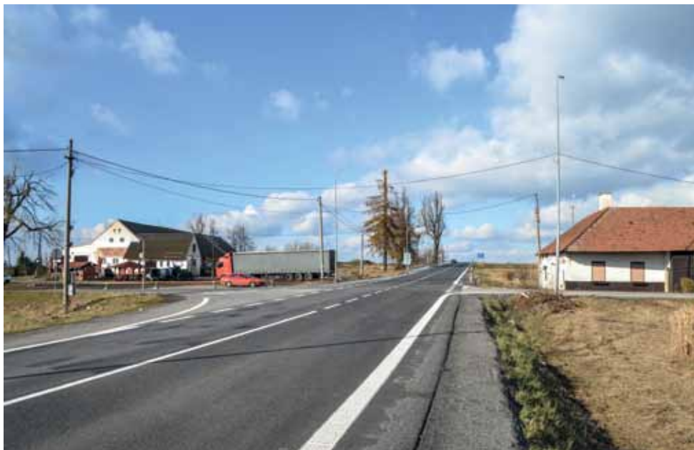
→ Křižovatka před rekonstrukcí
