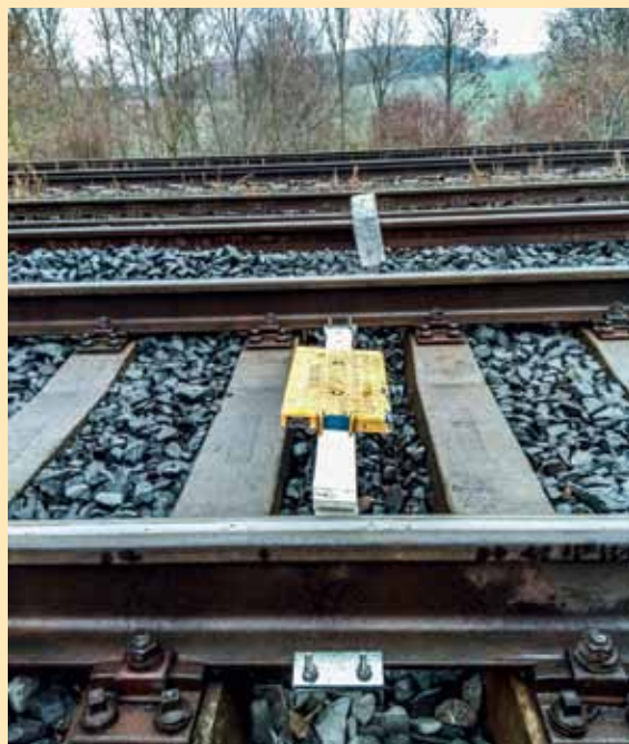
↓ Obr. 10 Natočení balízy v podélném sklonu
