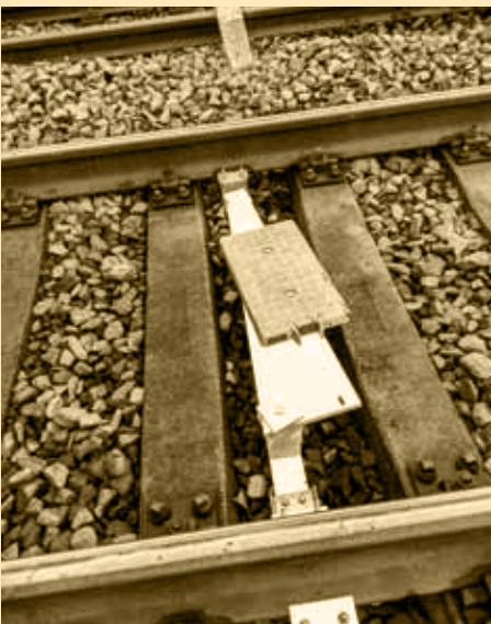
↑ Obr. 11 Natočení balízy v ose Z
