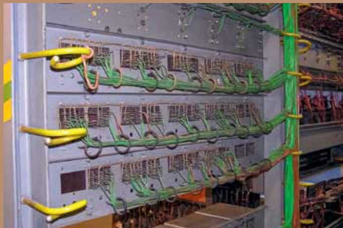
↓ Pohled na zadní stranu reléových stojanů – původní montáž přímo na patice relé
