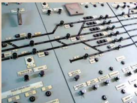
↓ Ovládací tlačítka cestového systému na pultu reléového zabezpečovacího zařízení typu AŽD 71
