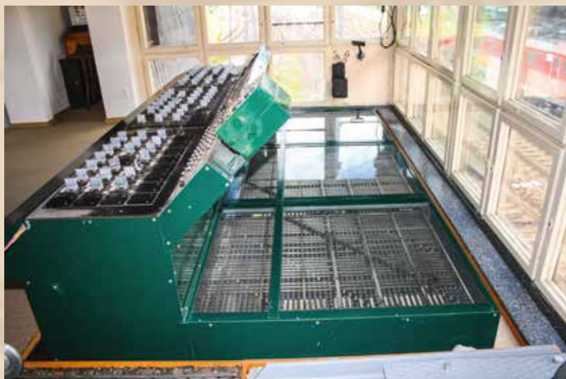
↑ Elektrodynamické stavědlo v Děčíně
