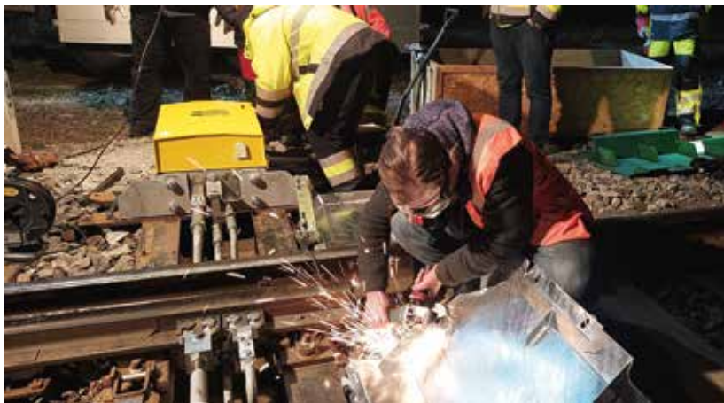
↗ Demontáž původního přestavníku SP-6M
