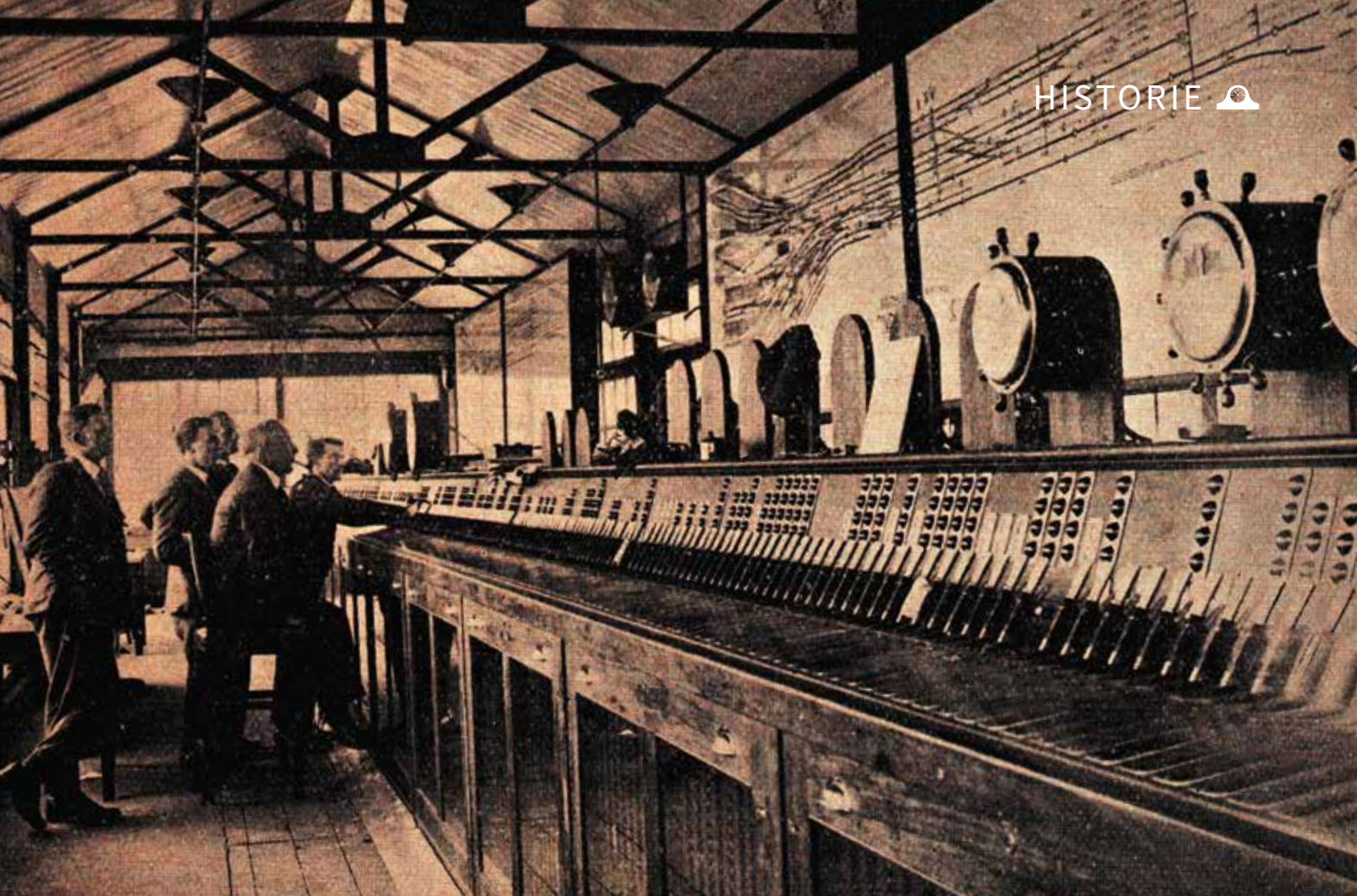
↑ Ústřední stavědlo v London Bridge
