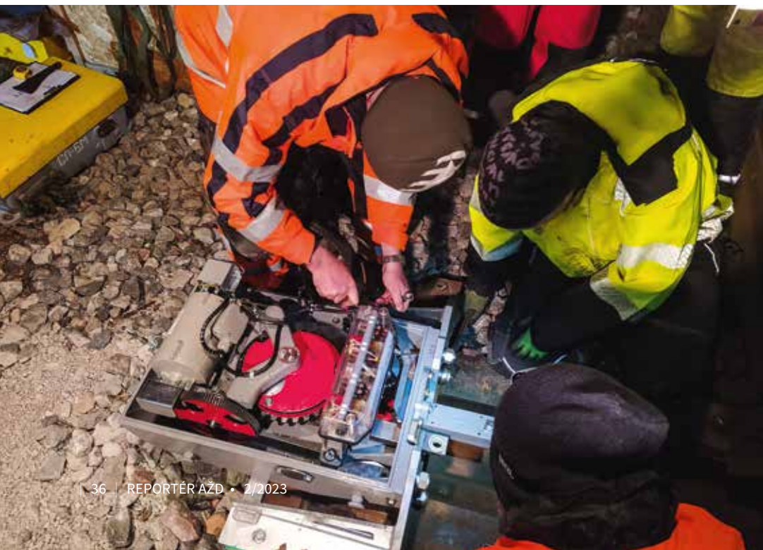
↗ Demontáž původního přestavníku SP-6M
