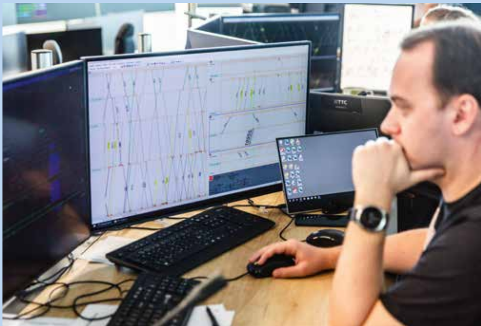
← Řídicí sál 3B CDP Praha, pracoviště traťového dispečera pro Prahu-Vršovice, monitor provozní aplikace GTN s ASVC
