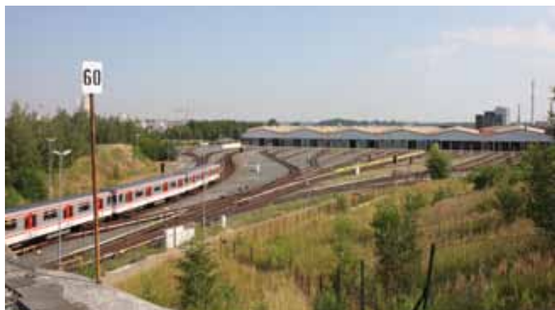
Kolejiště depa metra ESA M+
