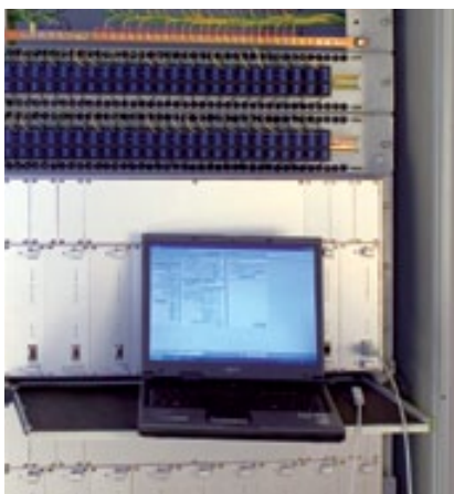
Штатив с рельсовыми приемниками TCR и диагностическим PC
