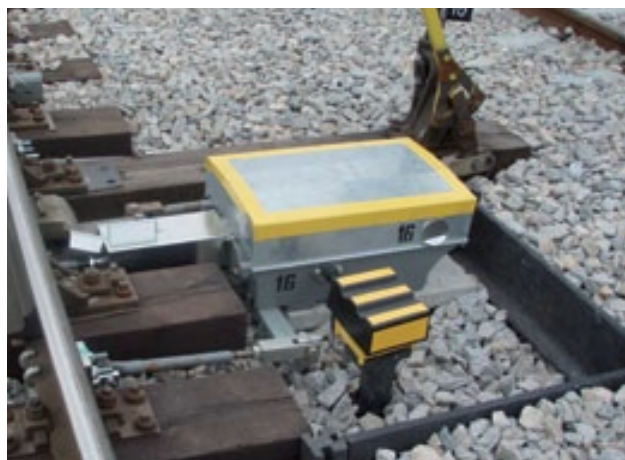
Шарнирная система крепления
