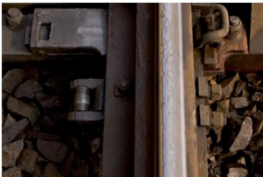
*Роликовая подкладка в прилегающем положении*
