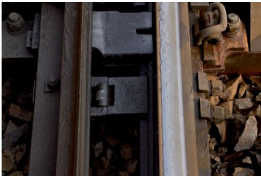
Роликовая подкладка в отдаленном положении
