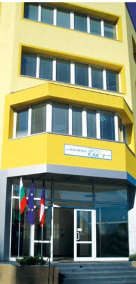
Pohled na novou budovu Balkan SAST
