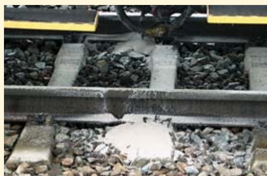
8 • ZABEZPEČOVACÍ ZAŘÍZENÍ V MORAVANECH NESELHALO
