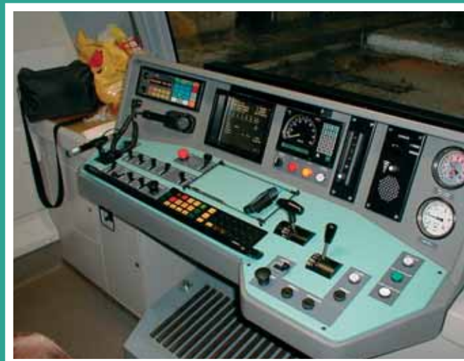
Pult strojvedoucího elektrické příměstské patrové jednotky ČD řady 471 s aplikovaným systémem CRV&AVV navázaným na vlakový zabezpečovač LS90
