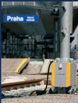
Ukolejnění – ochrana před úrazem elektrickým proudem
