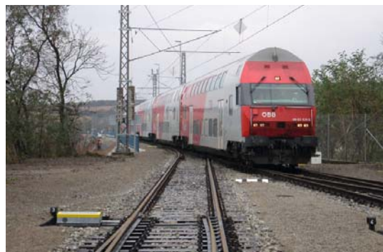
4 • PROVOZ NA ELEKTRIFIKOVANÉ TRATI ŠATOV–ZNOJMO ŘÍDÍ TECHNOLOGIE AŽD PRAHA
