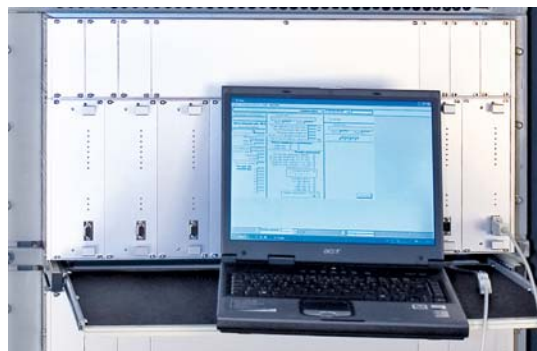
10 • NOVÁ ETAPA KOLEJOVÝCH OBVODŮ
