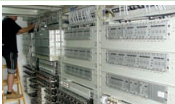
Montáž ESA 11-SB v srbské elektrárně TENT
