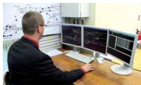
17 • ZKOUŠKA STANIČNÍHO ZABEZPEČOVACÍHO ZAŘÍZENÍ ESA 11 V RÁMCI REVITALIZACE ŽELEZ- NIČNÍHO UZLU ŽILINA
