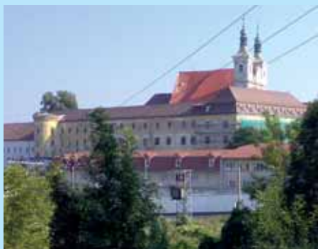
Celkový pohled na areál věznice v Ilavě
