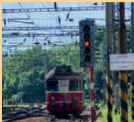
Návěstidlo L2 žst. Trenčín se zkráceným stožárem pro zaručení viditelnosti u nástupiště
