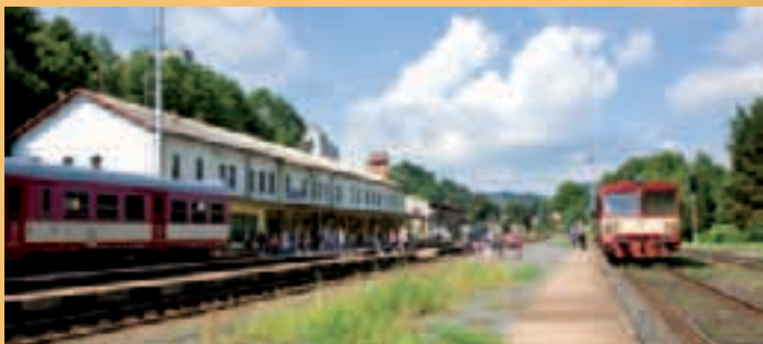
Železniční stanice Železný Brod
