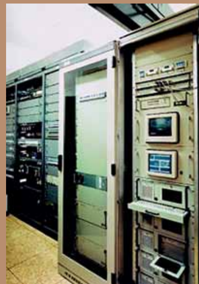
↓ Staniční zabezpečovací zařízení ETB
