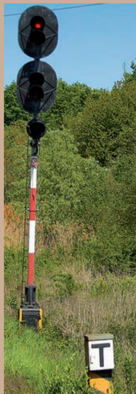
Vjezdové návěstidlo s „dodatečným“ bílým světlem přivolávací návěsti, Zemianske Kosťany
