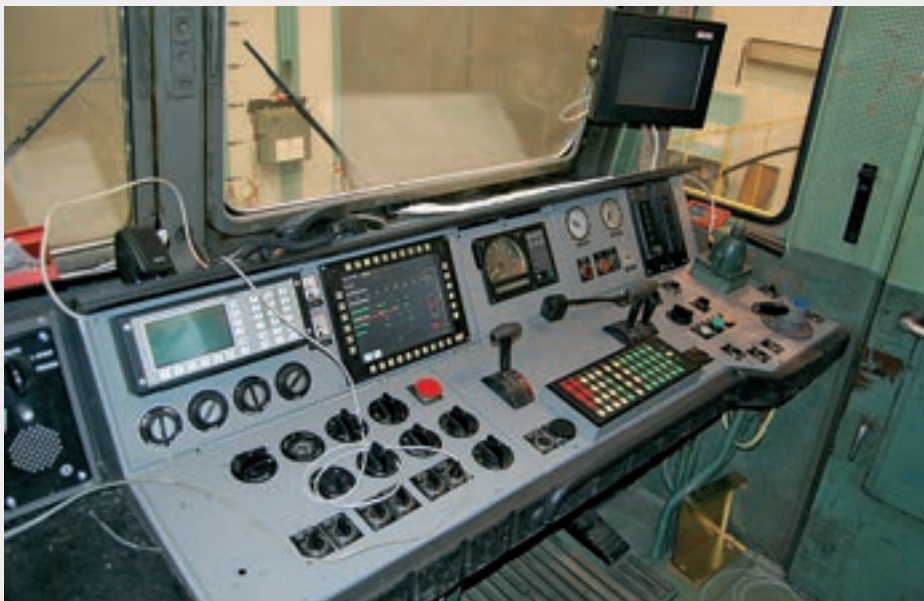
Stanoviště lokomotivy 362.166 během instalace ETCS (je již vybaveno zobrazovačem a dalšími ovládacími prvky systému CRV&AVV)
