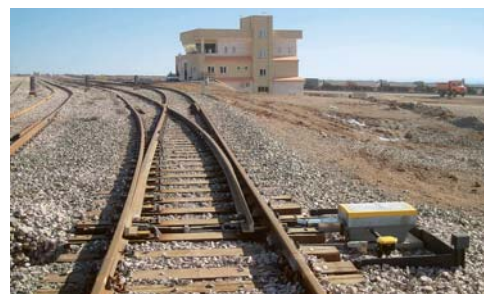
19 • ÍRÁNSKOU ŽELEZNIČNÍ STANICI V SANGANU ZABEZPEČUJE AŽD PRAHA
