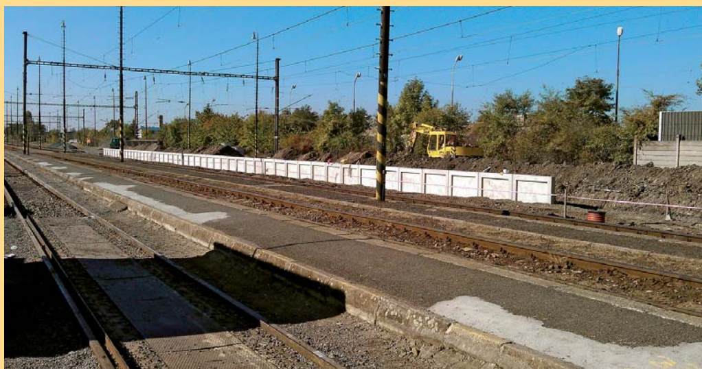
Výstavba nástupiště v Horních Počernicích
