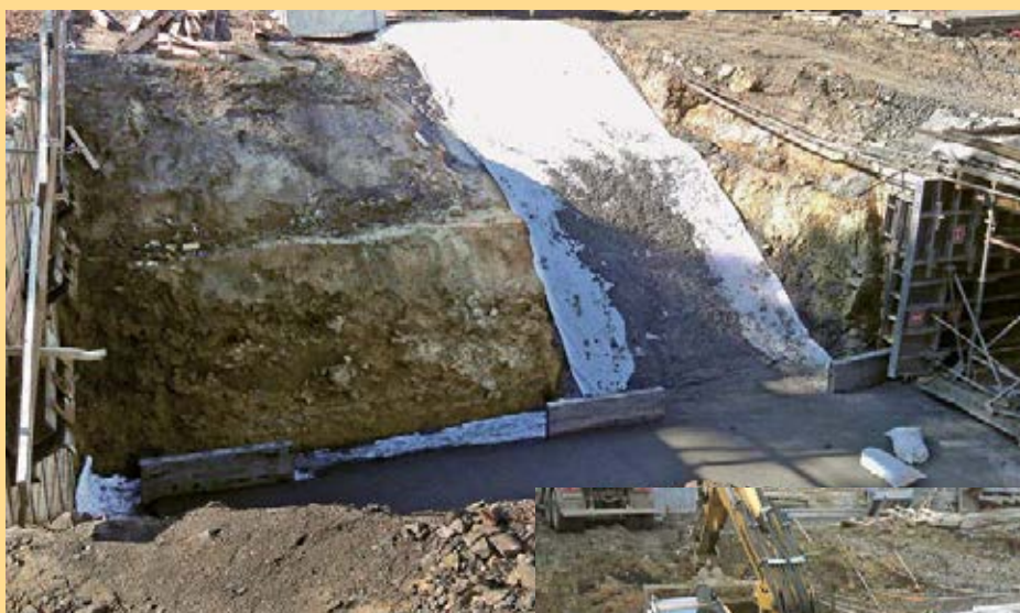
Výstavba podchodu a schodiště
