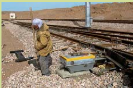
Montáž přestavníku AŽD Praha v Sanganu
