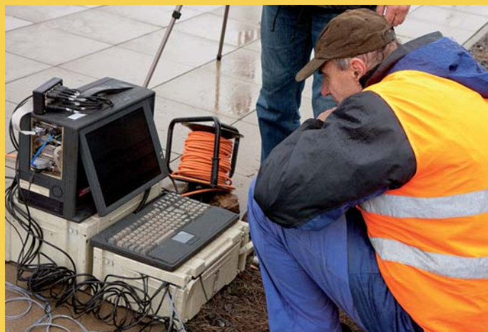
Měření vibrací na výhybkách
