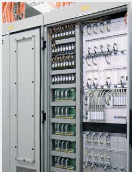
Skříň řídicích počítačů stacionární části LZA
