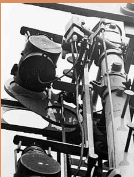
Údržba drátovodných tras ve žlabech a mechanických návěstidel patřila k namáhavým pracím
