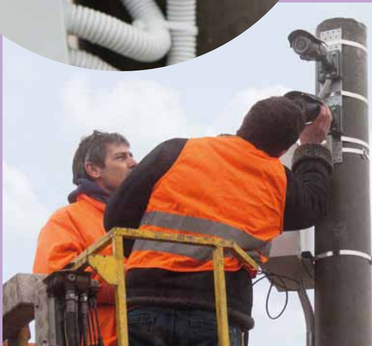
Na každé straně přejezdu jsou dvě kamery, z nichž jedna je nastavena tak, aby zabírala celý přejezd, a druhá eviduje registrační značky vozidel
