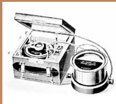
K měření elektrických veličin sloužily převážně jednoúčelové přístroje. Firma NADIR již na počátku 20. století dokázala drahý ručkový měřicí přístroj použít i v měřící soupravě
