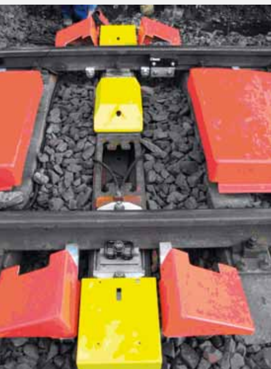
Traťová část systému ASDEK
