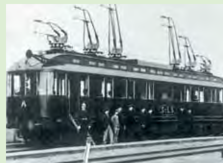
Obr. 11 V letech 1901 až 1904 ověřovaly tehdejší Pruské dráhy třífázovou trakční soustavu 3AC 10 kV 45 Hz. Tento vůz o uspořádání (A1A)'(A1A)' o délce 22 m s instalovaným výkonem 3000 kW dosáhl rychlosti 210,2 kmh -1
