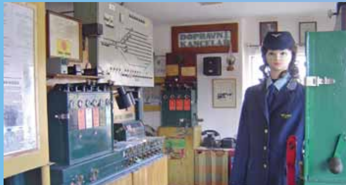
Železniční stanice Příbram, stavědlo č. 2 • Provozovatel Rakovnicko – Protivínská dráha, o. s., Bratří Čapků 330, 261 01 Příbram, telefon 725 397 434, 774 818 458 • www.rpdrahy.wz.cz , rakovnicko-protivinskadraha@email.cz
