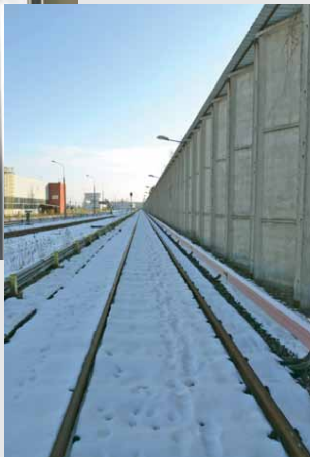
Zkušební úsek v depu metra Kabaty
