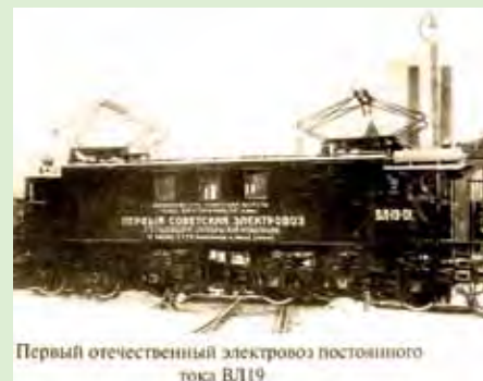
Obr. 5 První sovětská (ruská) lokomotiva pro napětí DC 3 kV značená VL 19. Její prototyp absolvoval zkoušky v roce 1935 právě na okruhu Ščerbinka
