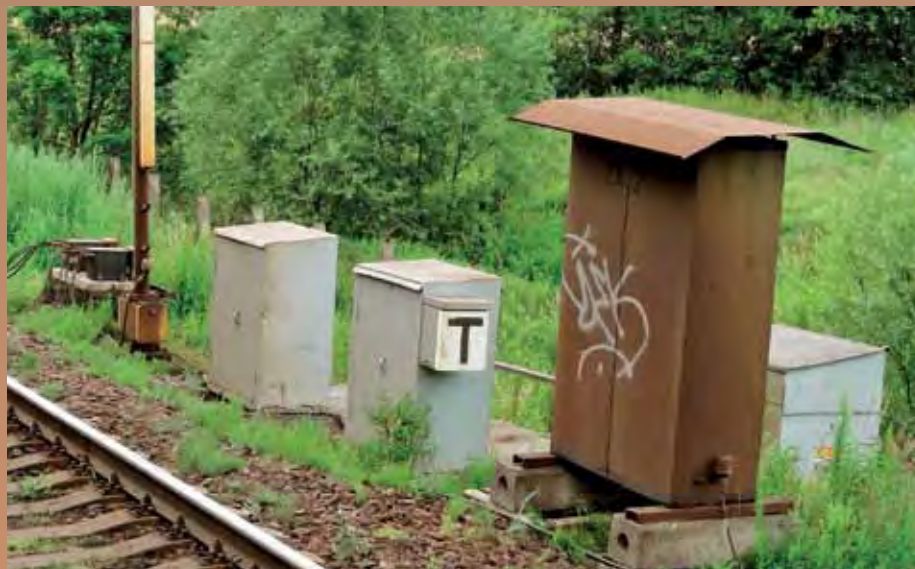
Reléová část původních automatických bloků byla instalována do reléových skříní typu ŠM 2 a ŠM 3. Teprve později je nahradily reléové skříně se zastřešením, které sice ve skříních snižovalo teplotu, ale údržbáře před nepohodou nechránily (foto z roku 2011)
