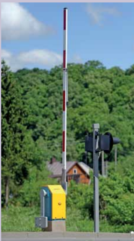
Přejezdové zařízení na trati
