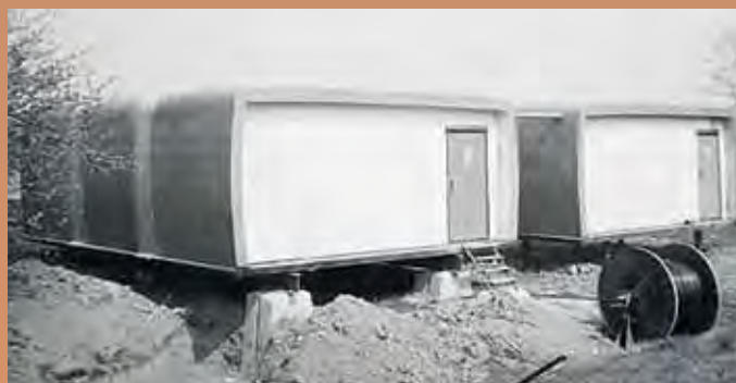
V 80. letech 20. století omezovala výstavbu zabezpečovacích zařízení nedostatečná kapacita stavbařů, což dokonce vedlo k „slepování“ sklo-laminátových domků (foto z roku 1982)
