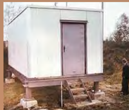
Jeden z domků mezi železničními stanicemi Olomouc hl. n. a Štěpánov s technologií návěstního bodu obousměrného automatického bloku a napájení z rozvodu 6 kV/50 Hz (foto z roku 1984)
