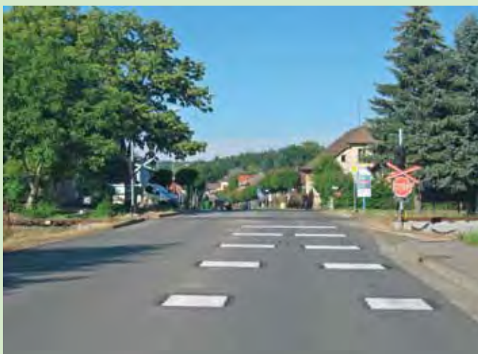
Obr. 2 Optická psychologická brzda (modifikované provedení) před železničním přejezdem zabezpečeným výstražným křížem
