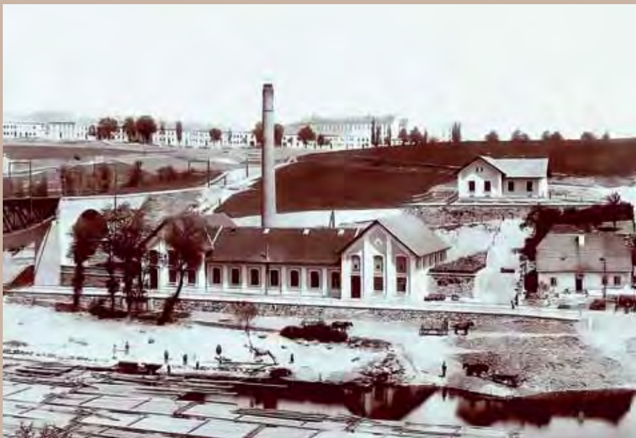
Budova parní elektrárny v Táboře. V letech 1903 až 1938 sloužila k napájení trakčních elektrických zařízení
