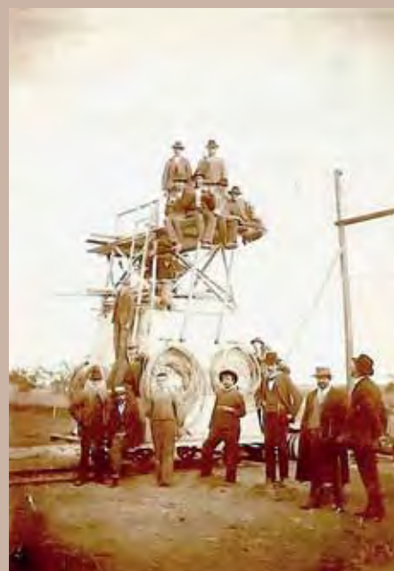
Kolejová plošina pro práce ve výškách při výstavbě trakčního vedení z let 1902 až 1903
