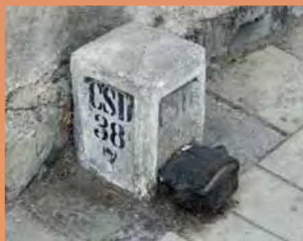
Kabelový označnický dálkového kabelu s vyvedenou kontrolní čtyřkou (foto z roku 2009)
