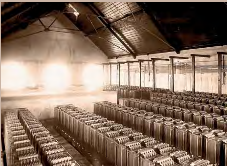
Baterie olověných kondenzátorů, která sloužila k omezení kolísání trakčního napětí
