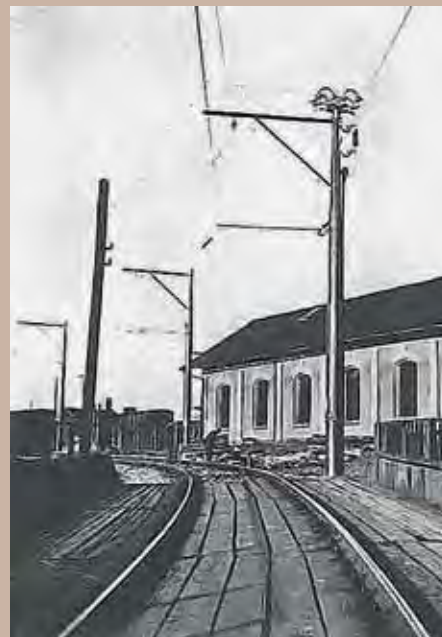
Stožár s úsekovým odpojovačem v žst. Tábor po rekonstrukci v roce 1938
