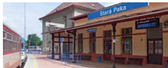
56 • STARÁ PAKA OCENĚNA V SOUTĚŽI ČESKÁ DOPRAVNÍ STAVBA/TECHNOLOGIE/INOVACE ROKU 2012
