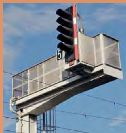
Moderní konstrukční řešení a zejména důkladná protikorozní ochrana snížily náklady na údržbu návěstních lávek a krakorců (žst. Zábřeh na Moravě, 2011)
