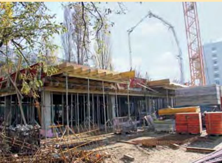
Výstavba nové budovy
