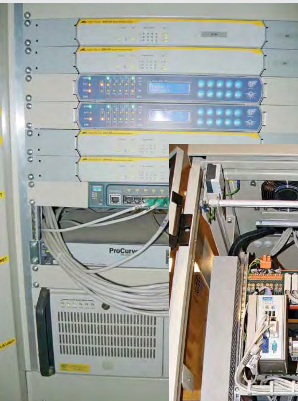
Obr. 4 Ověřovací provoz routerů DOR ve funkci jednosměrného oddělení
