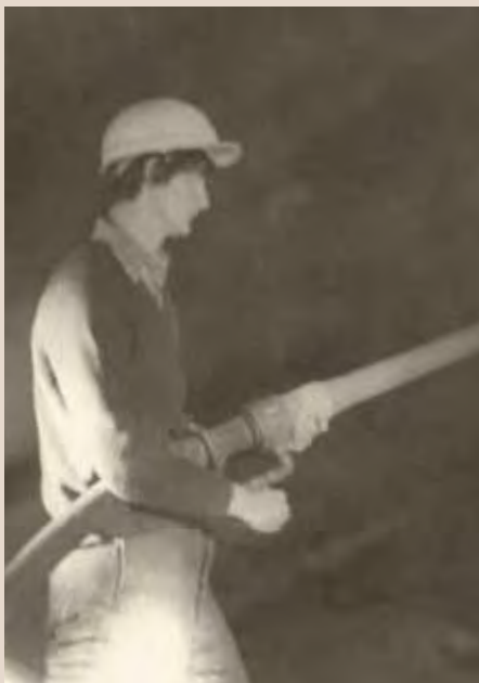
Na tunelu Mníšek (1979)
