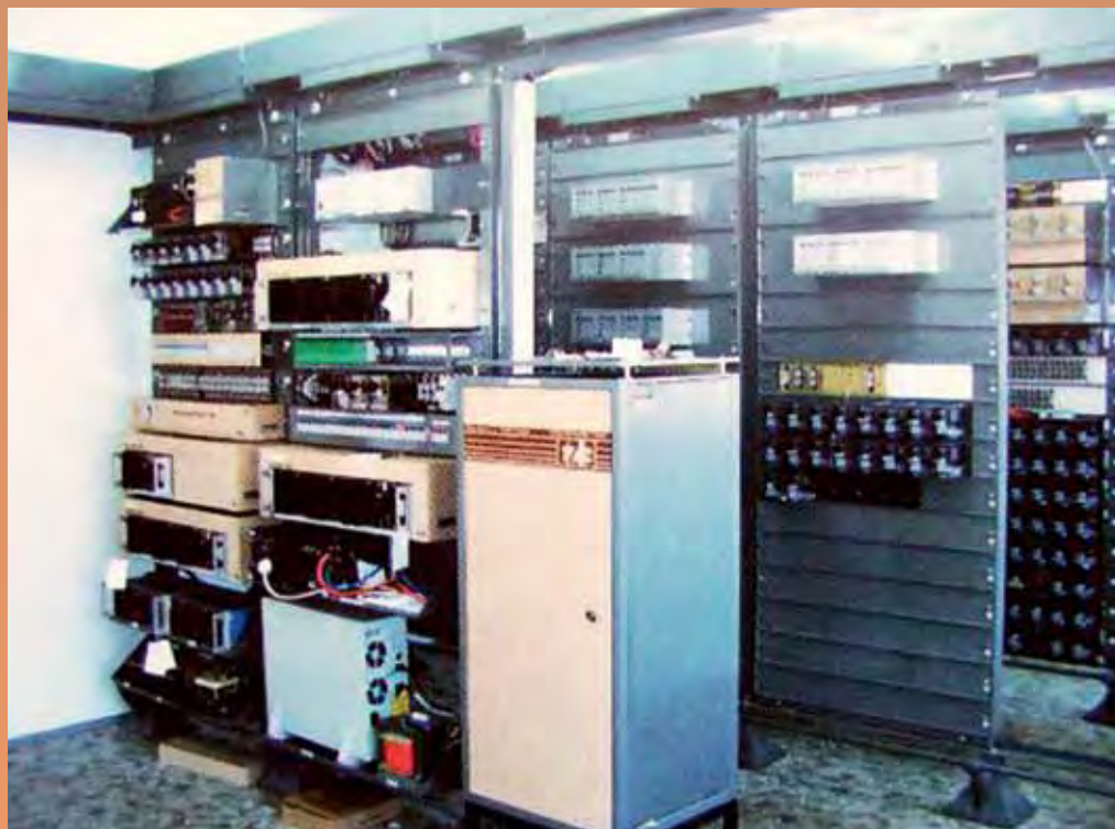
Stojan staničního zabezpečovacího zařízení kombinovaného – typ SZZK-98 a vpravo elektronické stavědlo typ K-2000 společnosti Starmon (reprodukce z prospektu Starmon)
