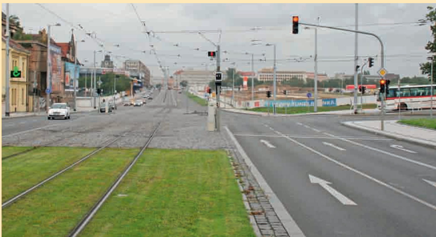
Výstavba křižovatky Špejchar na Letné
