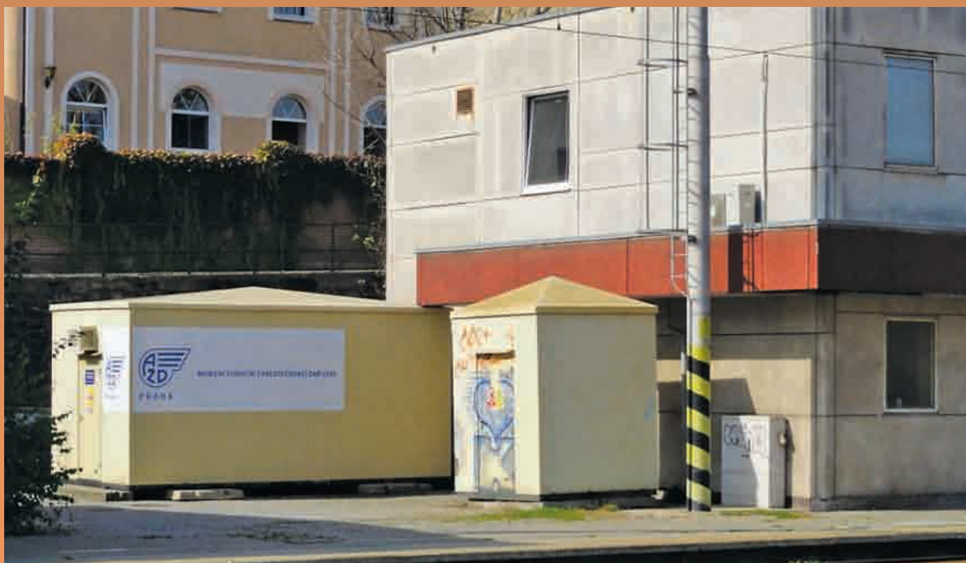
Mobilní kontejner AŽD Praha se zařízením ESA 11 (zcela vlevo) před objektem se zahořeným zabezpečovacím zařízením v žst. Roztoky u Prahy v srpnu 2010
