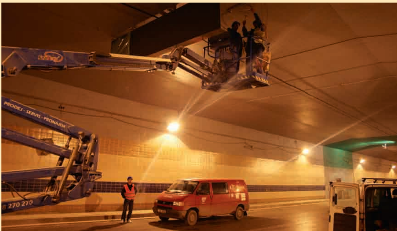
Montáž zařízení pro provozní informace (ZPI) – září 2013
