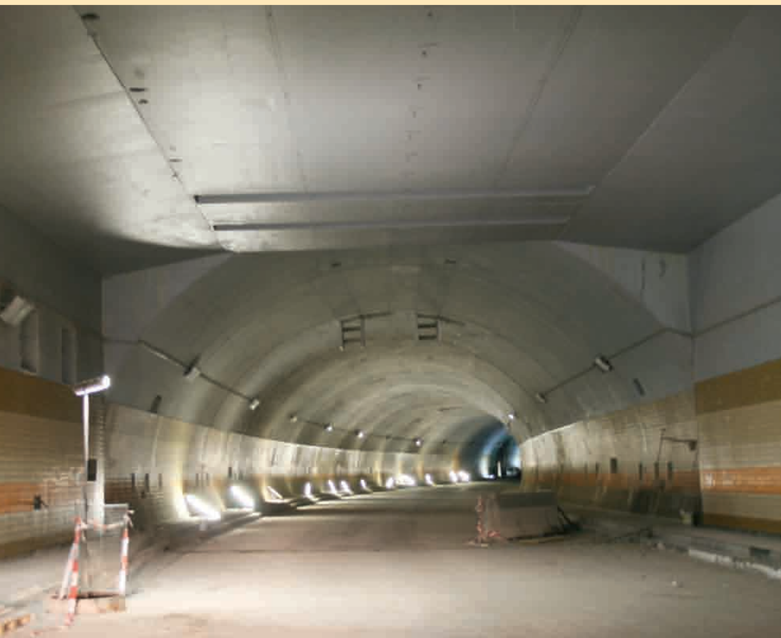
Přípravné práce v části tunelového komplexu – duben 2013
