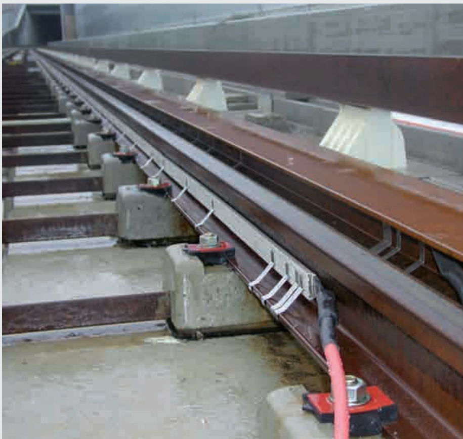
Obr. 1 El-Rail systém (elektrický ohřev kolejí německé firmy Eltherm)
