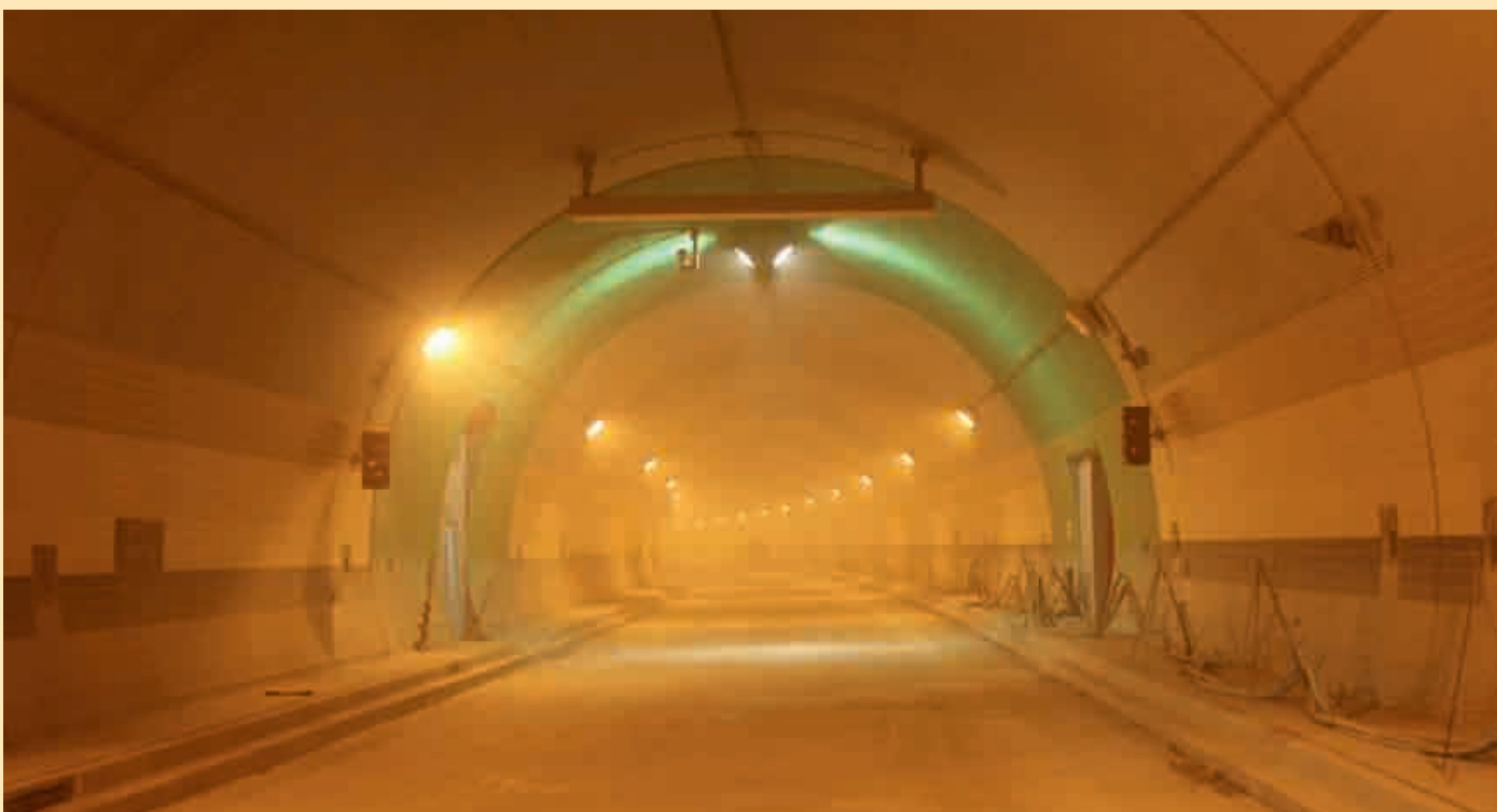
Montáž světelné signalizace – srpen 2013
