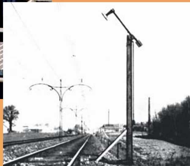
Mechanický snímač u návěstidla v poloze povolující jízdu a vlevo zakazující jízdu (žst Berlin – Am ZOO, S-Bahn, foto z června 2013)
