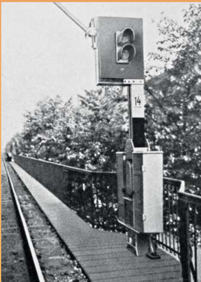
Umístění snímače na štítu světelného návěstidla u nadzemní dráhy
