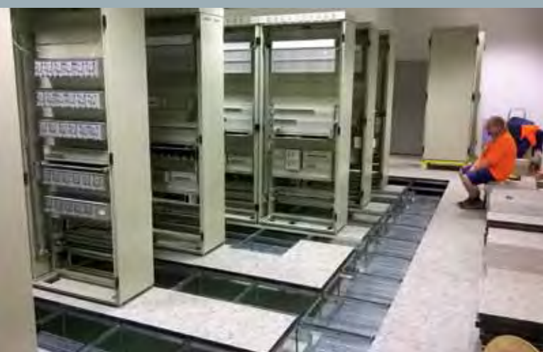
Montáž kabelových žlabů ve dvojité podlaze
