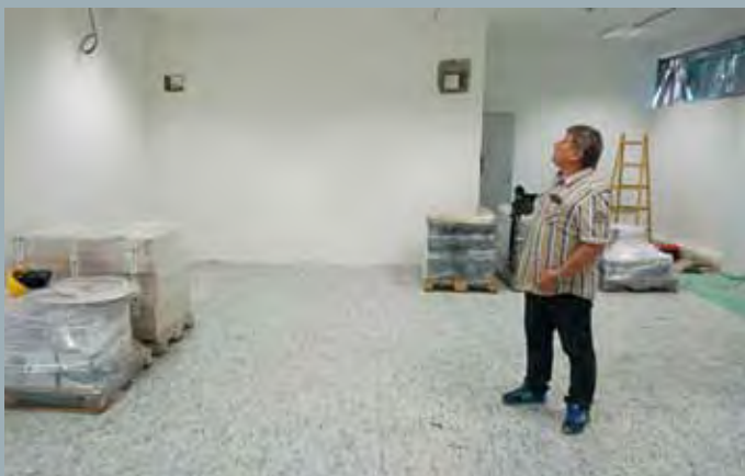
Kontrola stavebního ústředí po rekonstrukci
