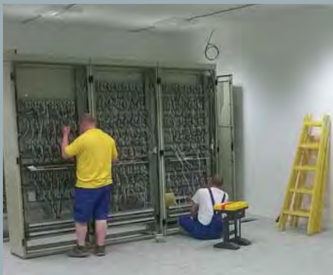
Zapojení počítačů náprav ACS2000
