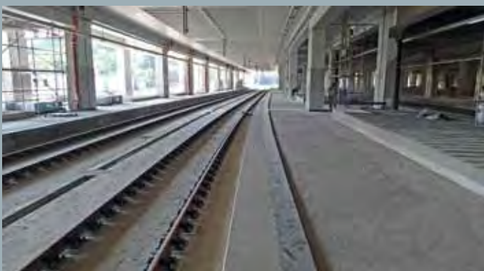
Finální práce na nástupištích a na 3. a 4. koleji
