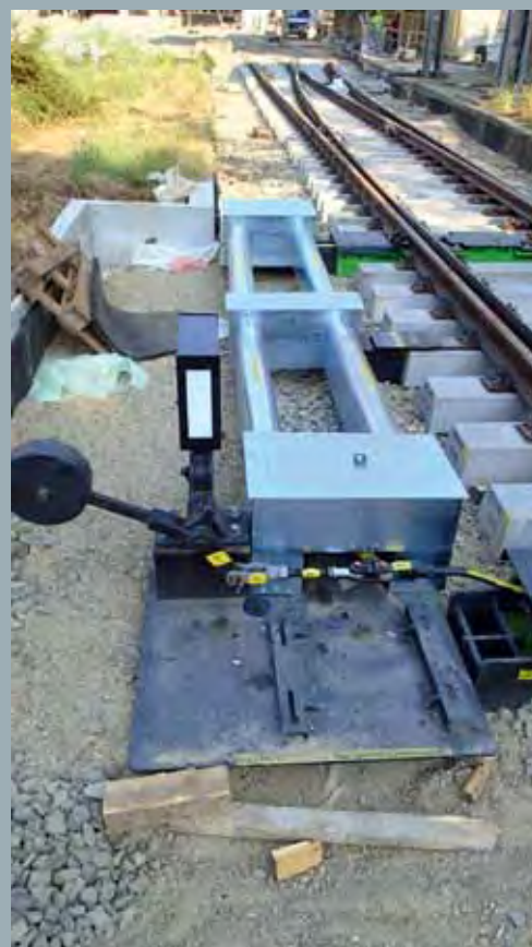
Nová výhybka před montáží přestavňáku EP644
