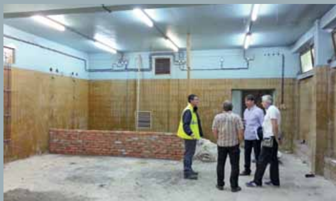
Začátek rekonstrukce stavebního ústředí
