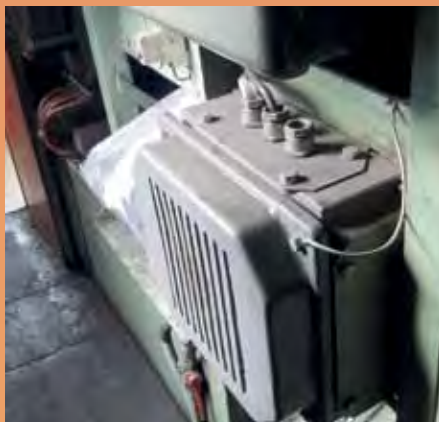
Skříň rotačního měniče pro mobilní část LVZ s krytem a bez (sbírka autora)
