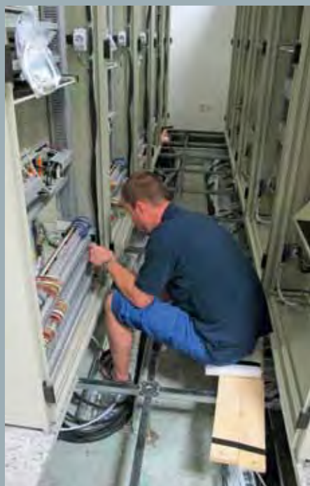
Zapojování vnitřních kabelů
