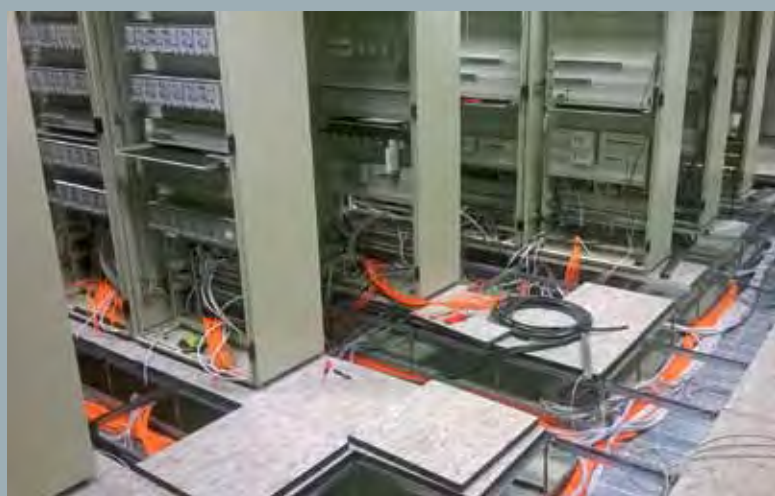
Pokládka vnitřních kabelů
