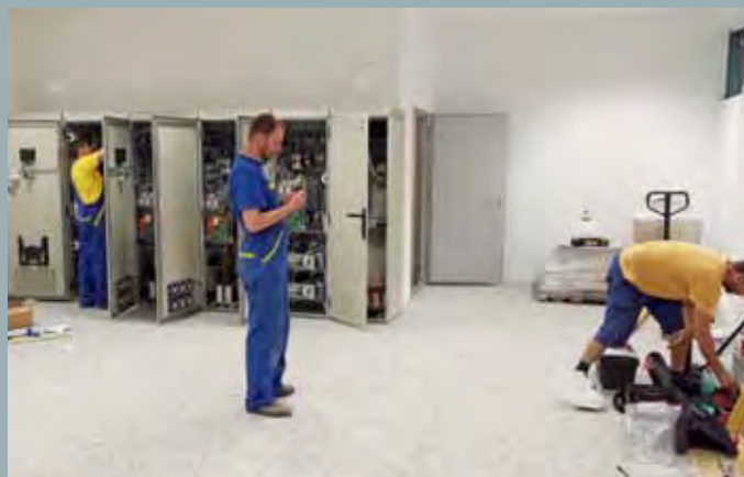
Montáž napájecího zdroje UNZ
