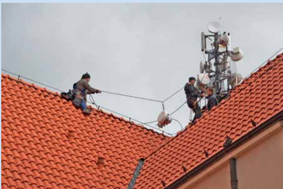
Hněvín – montáž směrového spoje
