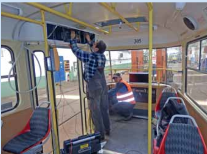
Instalace informačního systému v tramvajích
