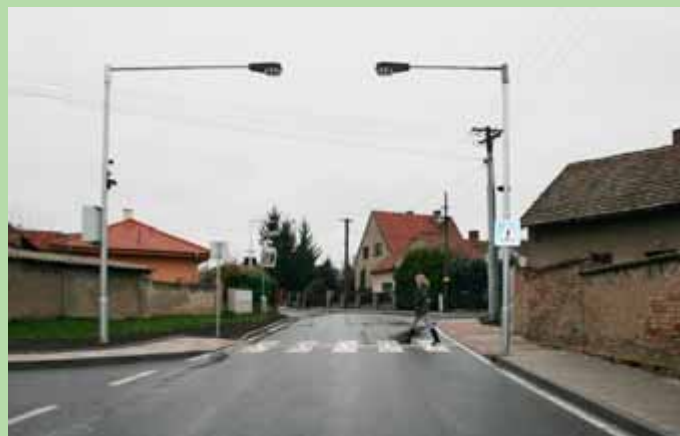
Světelně řízený poptávkový přechod s funkcí „zpomalovacího semaforu“ v ulici Školná (původní a současný stav)
