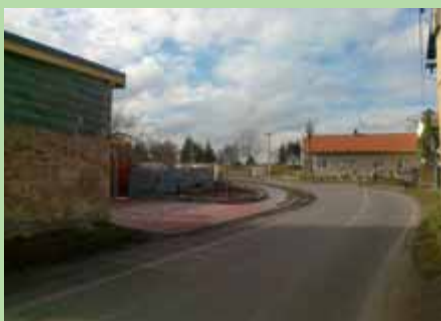
Důležitou součástí projektu byla demolice domu v ulici Školská (původní a současný stav)
