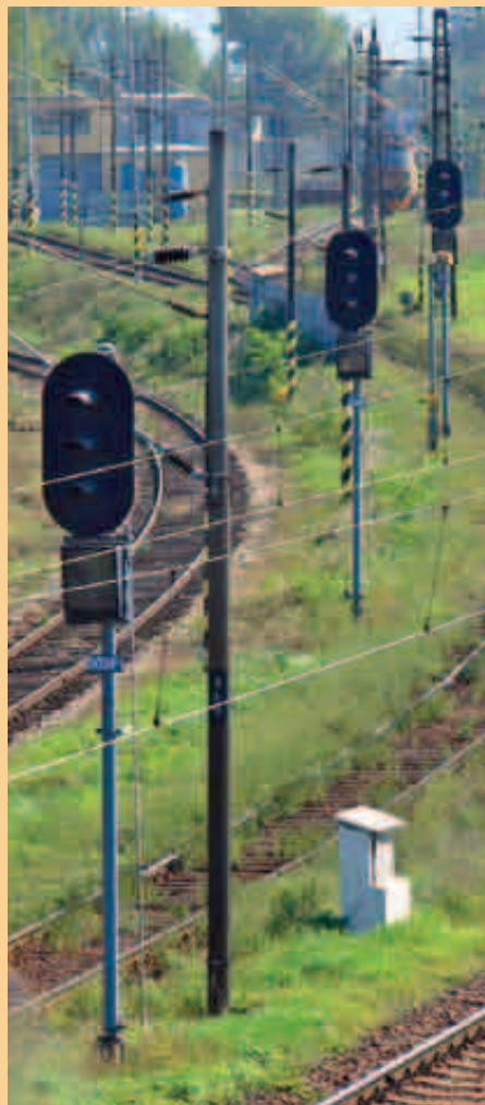
Integra – spádoviště, Štúrovo
