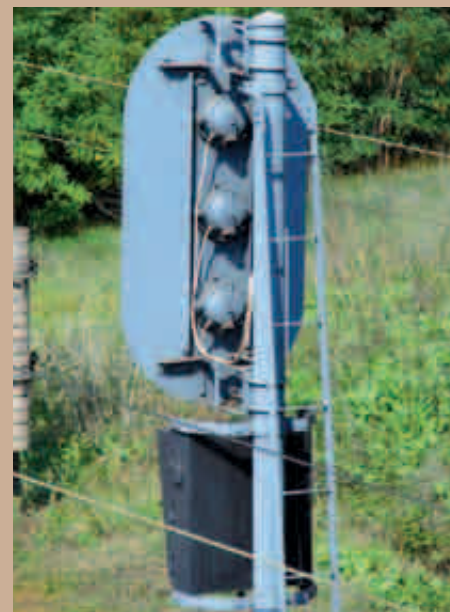
Integra – spádoviště, Štúrovo
