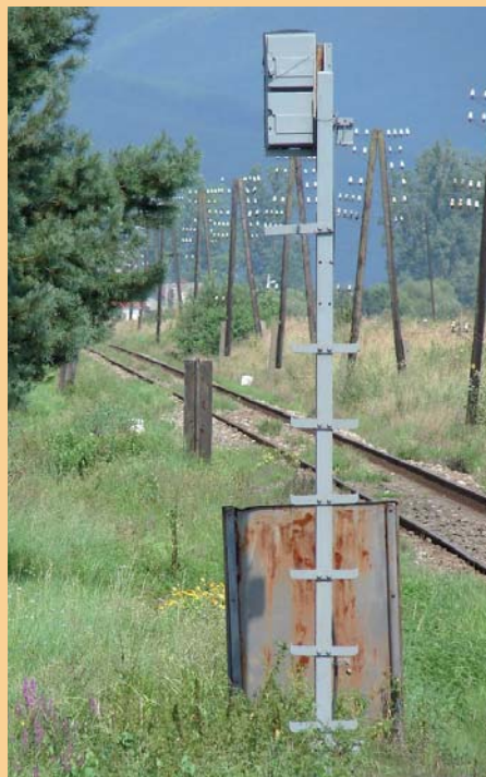
AŽD 70 s „hrnatými“ a „oblými“ stínidly na základě ESP, Žilina seřaďovací stanice
