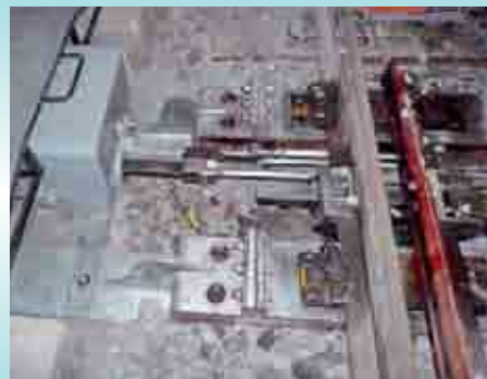
Přestavník firmy Dimetronic s příslušenstvím
