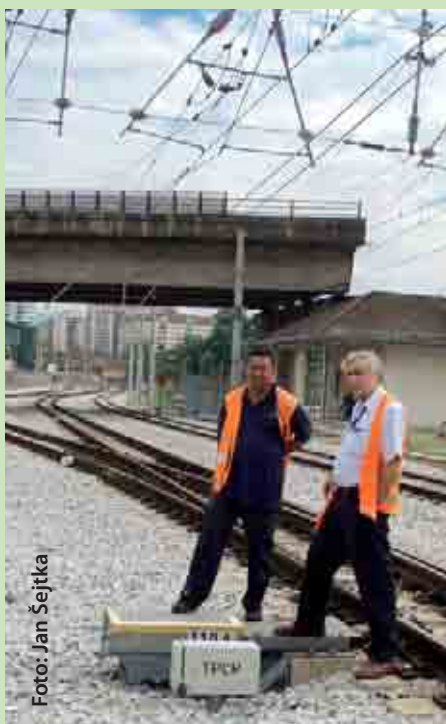
Kontrola českých přestavníků dopadla na výbornou
